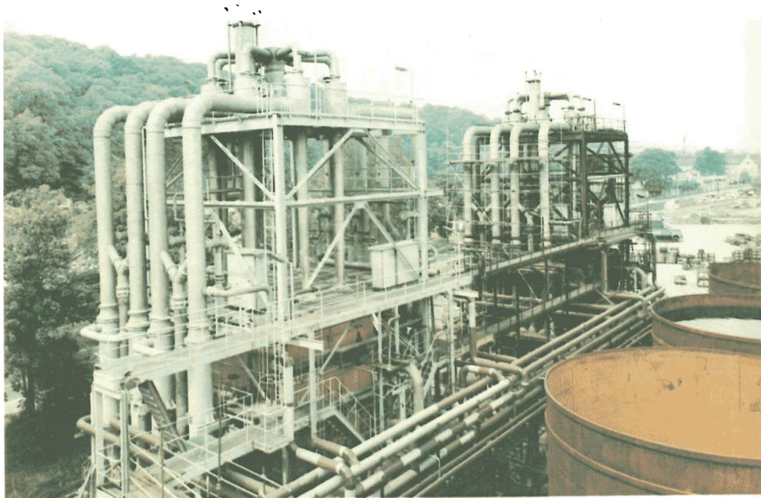
Oben: Biofabrik, die Futterhefe aus Sulfitablauge erzeugt und damit gleichzeitig sauberes Wasser liefert. (Pirna, DDR)
