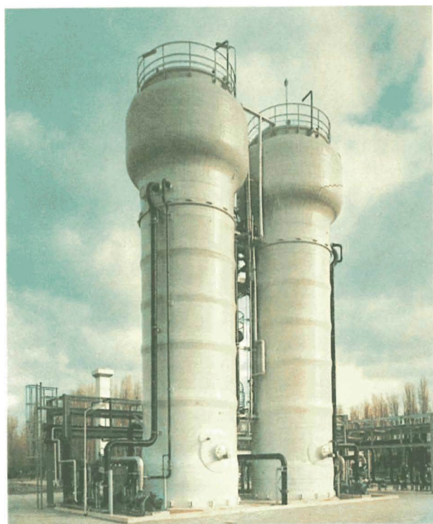
Oben: Biofabrik, die Futterhefe aus Sulfitablauge erzeugt und damit gleichzeitig sauberes Wasser liefert. (Pirna, DDR)
