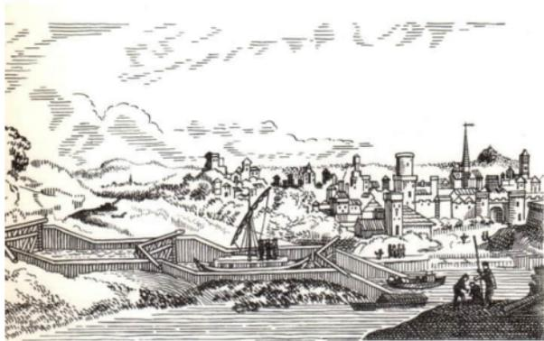
**Kanäle** verknüpfen die schiffbaren Flüsse zum Netz der Wasserstraßen. Um die Wasserscheiden zu überwinden, sind sie mit Schleusen versehen. In alten Kanälen folgten oft viele kleine Schleusen wie Treppenstufen aufeinander.
