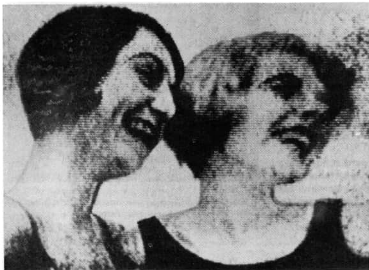
Bild 3.2 Fernsehbild mit 100 Zeilen, wie es Manfred von Ardenne auf der 8. Berliner Funkausstellung 1931 vorführte. Quelle: Geschichte der Technik. – Leipzig, 1978
