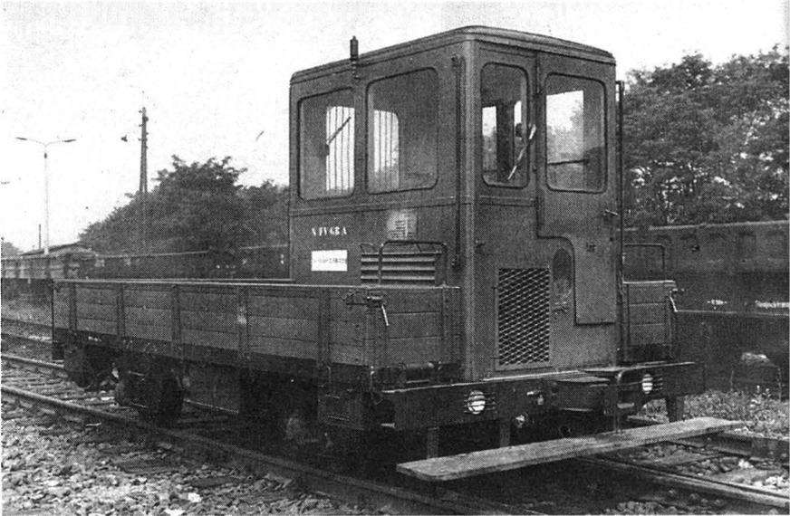
*Bild 5.36.* Schienenkleinkraftwagen (SKL)
