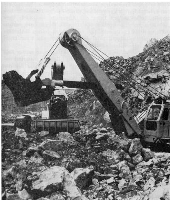
Bild 25. Im Kalksteinwerk Rübeland (Harz)
