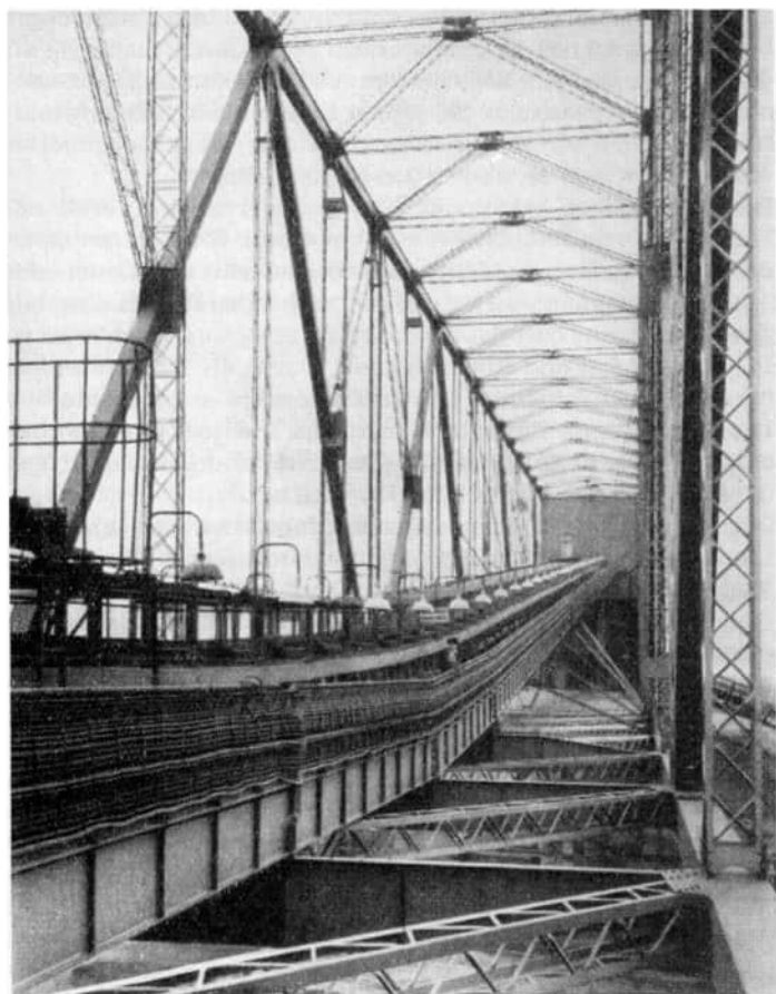
Bild 29. Die Förderbrücke von Klettwitz ist Beispiel einer modernen Stahlkonstruktion
