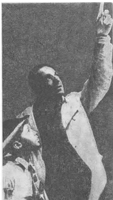
Bild 14. A. N. Grigorjanz , der Chefsingenieur des Kernkraftwerkes, erklärt einem Pionier den Aufbau des KKW (Archiv des Staatlichen Historischen Museums)
