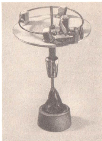
Hertzscher Sender mit Reflektor für Dezimeterwellen (Strichzeichnung von H. HERTZ)
