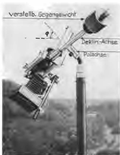
Abb. 29 Parallaktische Feldstecheraufstellung mit angesetzter Kamera. Ausführung und Photo J. BÜHNER, Thal bei Eisenach
