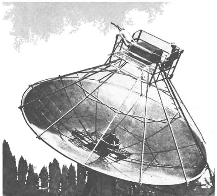
Abb. 12. Eine Sonnenanlage des heliotechnischen Laboratoriums des Energetischen Instituts der Akademie der Wissenschaften der UdSSR. Der Spiegeldurchmesser dieser Anlage beträgt 10 Meter.
