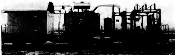
Bild 109. Fahrbare Energieverteilungsanlage (VEB Otto Buchwitz, Dresden)
