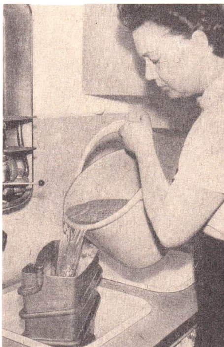
Bild 425. Beim Herausnehmen des Wärmeaustauschers darf nicht die Bimetallsicherung (Pfeil) beschädigt werden!
