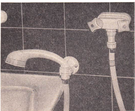
Bild 416. Mischbatterie mit Porzellankörper für Brause und Wanne, Modell „22719“
