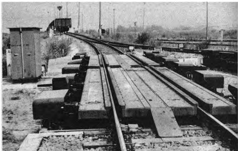
Balkengleisbremse Bauart FEW auf einem Ablaufberg
