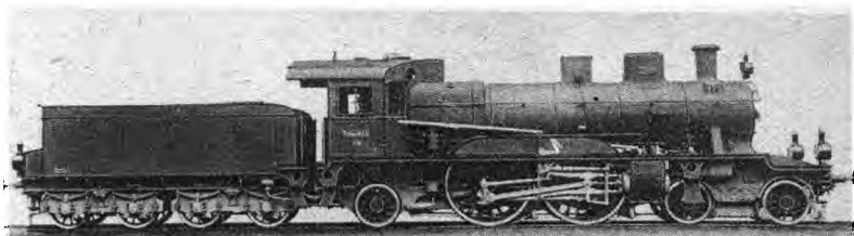
Schnellzuglokok (Naßdampf-Verbundlokomotive) der Königlich Sächsischen Staatseisenbahn, Baujahr 1900
