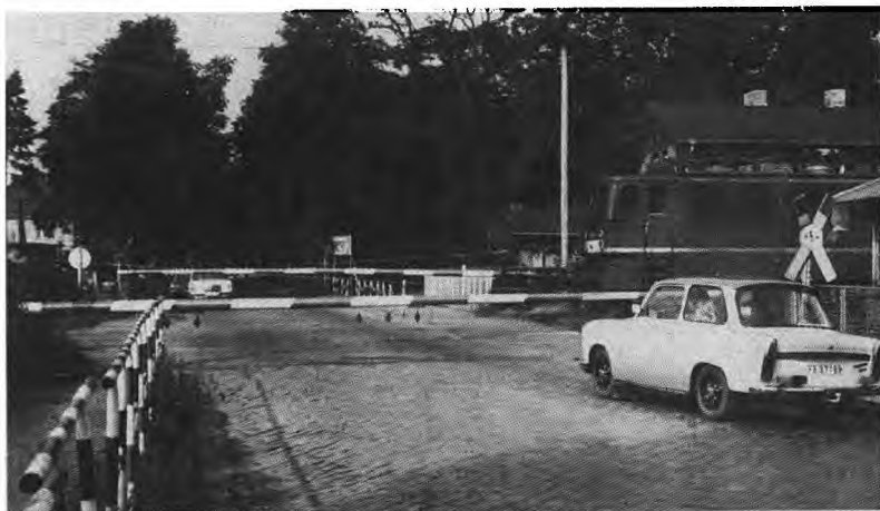
Schranksenanlage: Vollschrankenanlage
