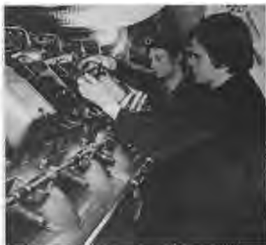
Fahrzeugschlosser bei der Instandhaltung einer Diesellokomotive
