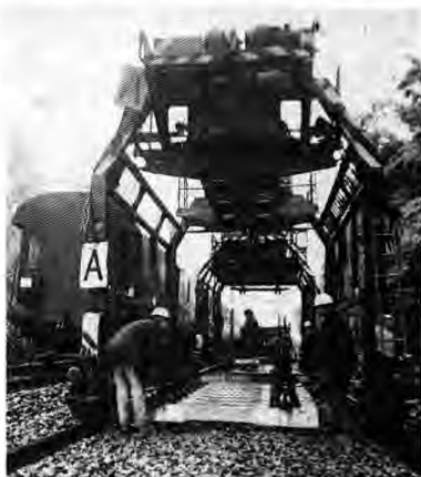
Gleisjochverlegung mit modernen Großgeräten erleichtert die schwere körperliche Arbeit beim Gleisbau
