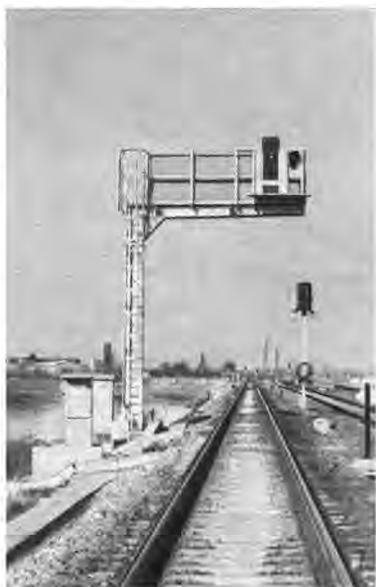
Signalanlage: Signalbrücke zur Aufnahme eines Signals
