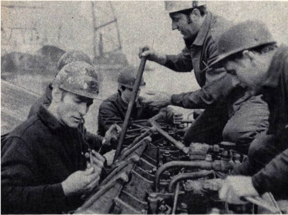
19 Junge Neuerer der Rostocker Neptunwerft bauten eine Vorrichtung zum Reiben und Bohren von Paßlöchern für die Fundamente der tonnenschweren Hauptmaschine.
