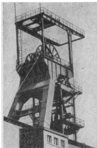
Bild 48. Stahlgerüst einer Fördermaschine
