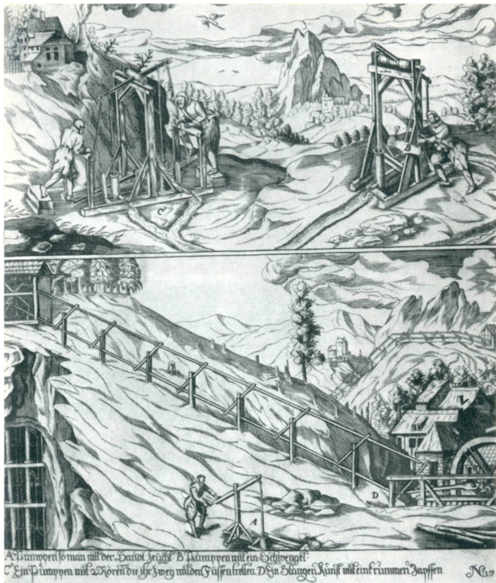
Pumpeinrichtung zur Ent- wässerung von Bergwerken
