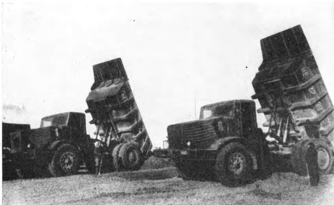
Irkutsk an der Angara; Hinterkipper MAS-525 für 25 t Zuladung an der Baustelle des Wasserkraftwerkes Irkutsk
