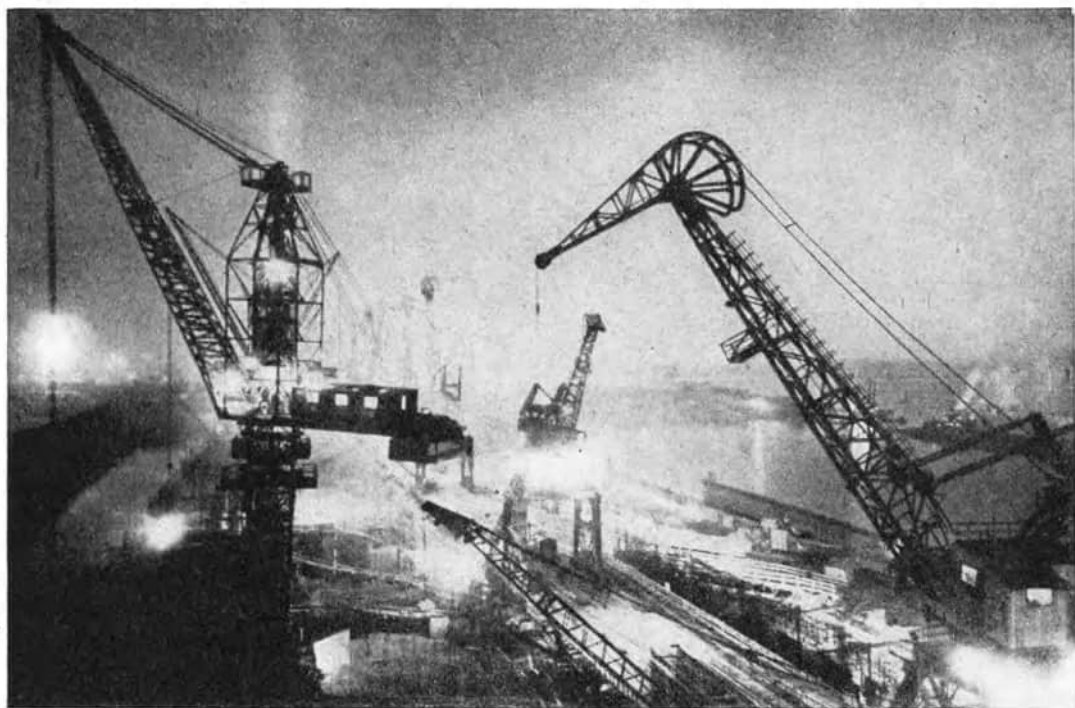
Bauplatz des Hydrokraftwerkes Irkutsk an der Angara, April 1956
