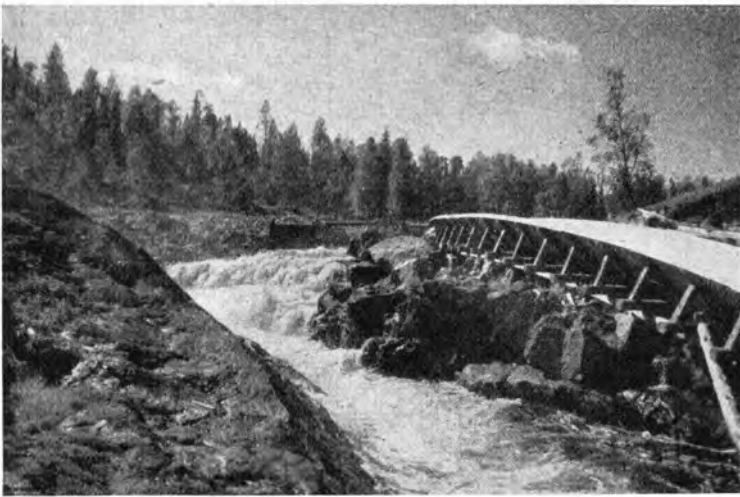
Ein kleiner Kanal aus Brettern zum Umgehen der Stromschnellen für die Flößerei
