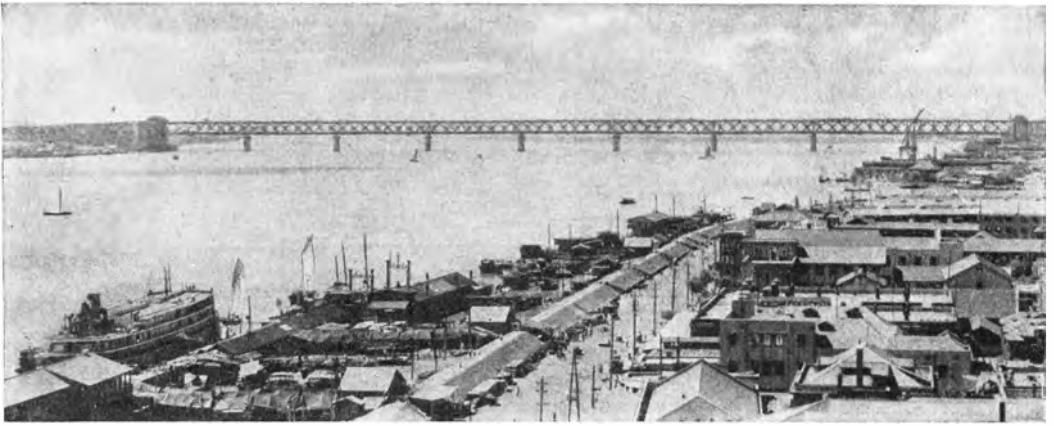
Blick auf die Jangtse-Brücke, die den Norden mit dem Süden des Landes verbindet
