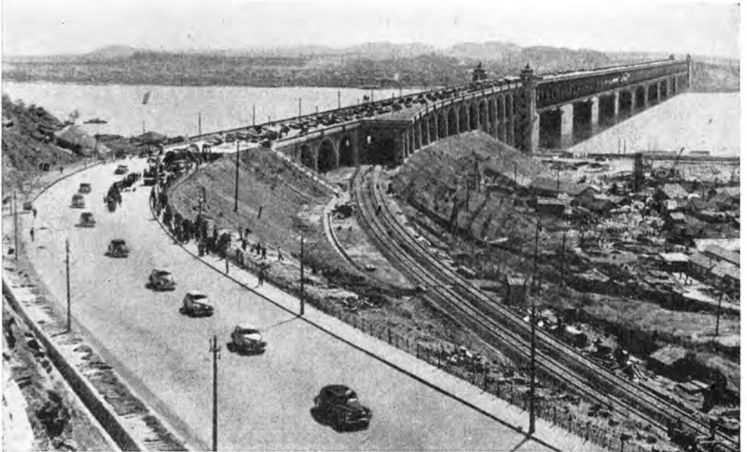
Die neue Doppelstockbrücke über den Jangtse – ein Wunderwerk der Technik. Probeverkehr auf der Autostraße der Jangtse-Brücke vor der offiziellen Freigabe
