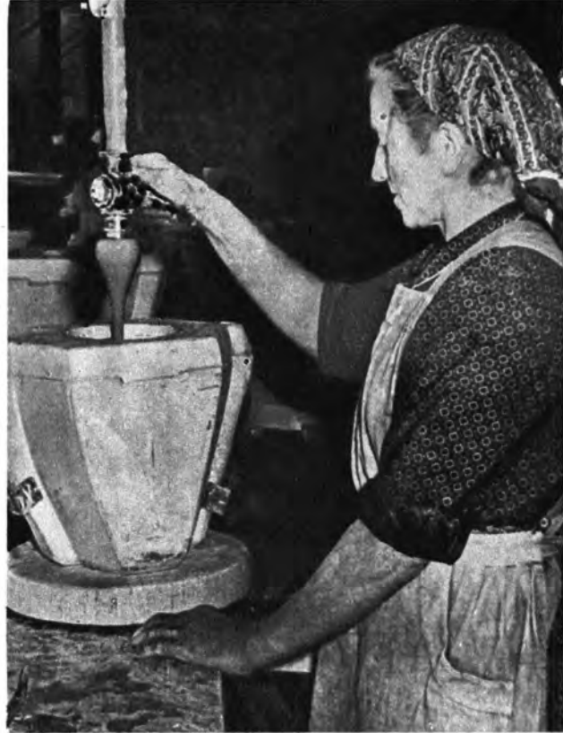
Alte und neue Technik in der Gießerei. Der schwere Gießbottich (links) hat ausgedient. An seine Stelle ist die Gießleitung getreten. Eine Drehung am Hahn (rechts), und die Masse fließt in die Form
