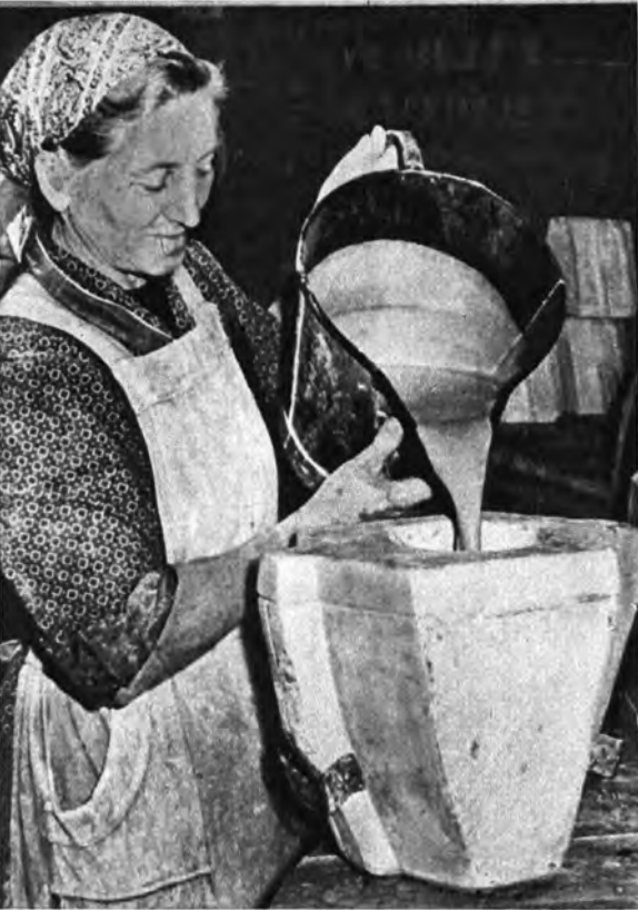
Alte und neue Technik in der Gießerei. Der schwere Gießbottich (links) hat ausgedient. An seine Stelle ist die Gießleitung getreten. Eine Drehung am Hahn (rechts), und die Masse fließt in die Form
