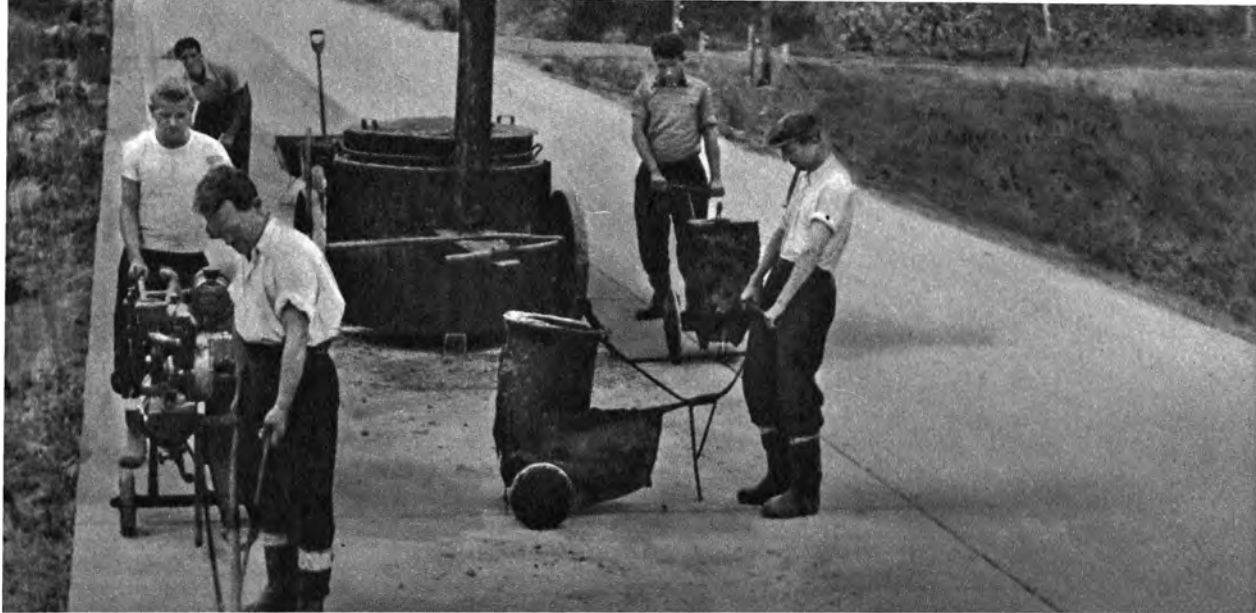
Wo einst Träger und Karren tief in den Boden versanken, entstehen moderne Betonstraßen
