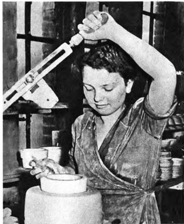
Alte und neue Technik beim Becherdrehen. Früher wurde die Schablone mit der Hand geführt, jetzt wird die gleiche Arbeit mit Becherautomaten schneller, bequemer und besser ausgeführt
