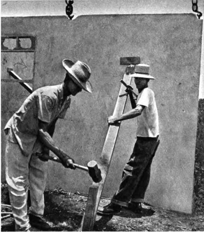
Die Wand wird bis zum Verschweißen gestützt. Häuserbau in der Fisch-Cooperative von Manzanillo
