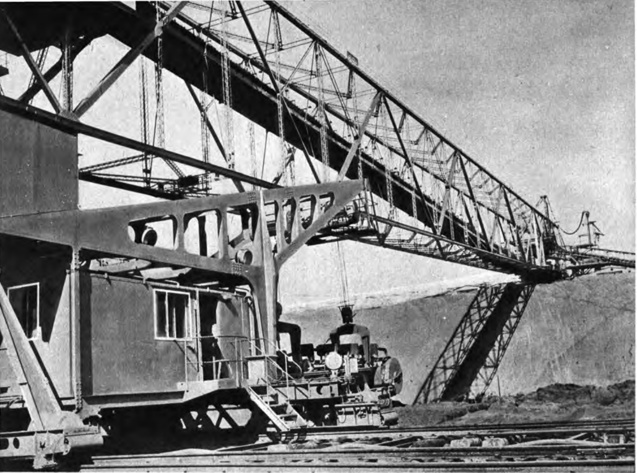
Die Förderbrücke in Leichtbauweise im Tagebau Sedlitz ist 280 m lang. Die Materialeinsparung gegenüber der bisherigen Bauweise beträgt 750 t. Mit einer erstmalig aufgewandten Bandgeschwindigkeit von 7 m/s fördert die Brücke 7600 m³/h, das ist das Doppelte der bisher üblichen Leistung
