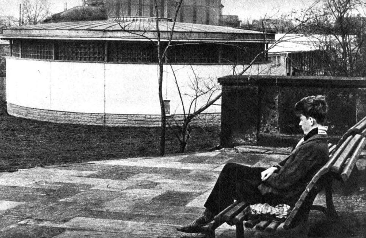
Der Rundbau, in dem sich das Trainingsbecken befindet
