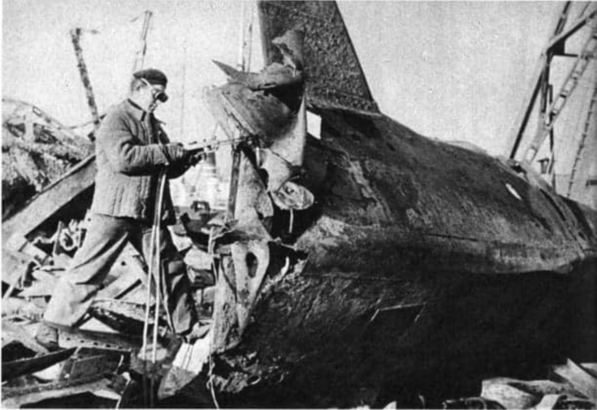
Ein gehobenes Wrack wird verschrottet. Die Stahlgießereien erhielten auf diese Weise mehr als 200 000 t wertvollen Stahlschrott
