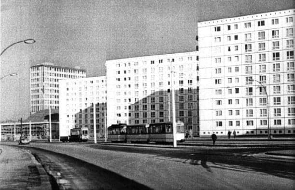
Gefällig wirkende Verkleidung der Großblockbauten am Alexanderplatz in Berlin, die durch Verwendung weißer Kacheln und anderer schmückender Elemente erreicht wurde
