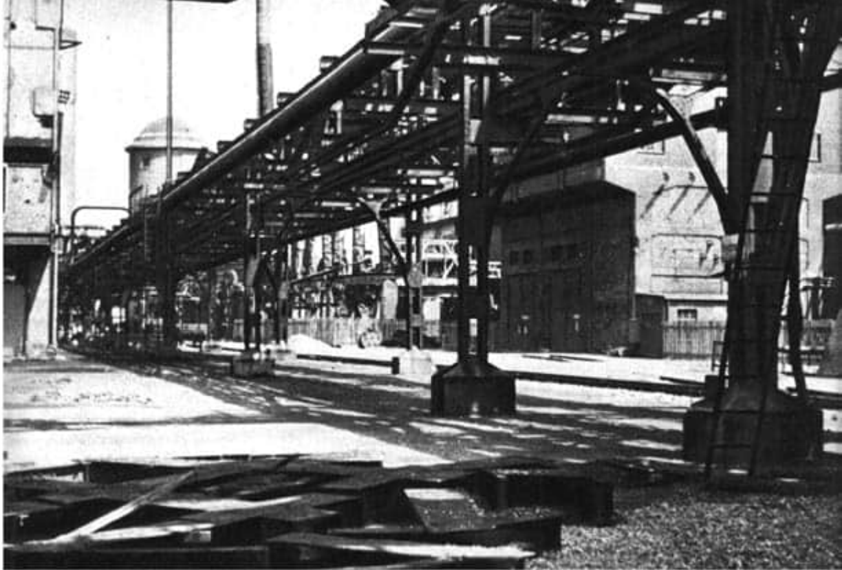
Die im Bild links abgebildete im Krieg zerstörte Rohrbrücke nach dem Wiederaufbau
