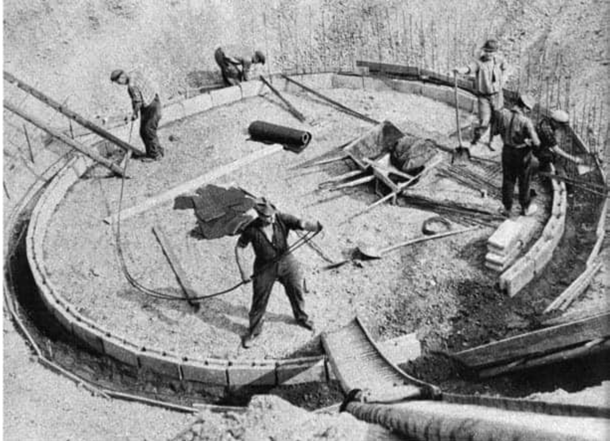
Bau eines Filterbrunnens der zentralen Abwasseraufbereitung (Werk II)
