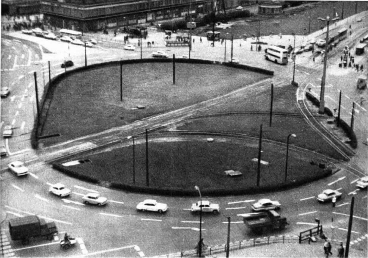
Der Kreisverkehr am Alexanderplatz vor Beginn der Bauarbeiten
