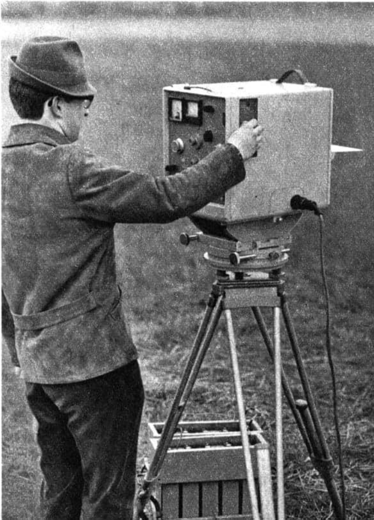
Elektro-optisches Streckenmeßgerät EOS
