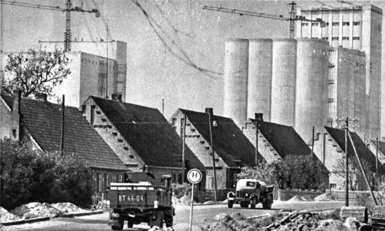
Das Kraftfuttermischwerk Wüstmark (Schwerin) wird eine Jahresproduktion von 100000 t Kraftfutter haben
