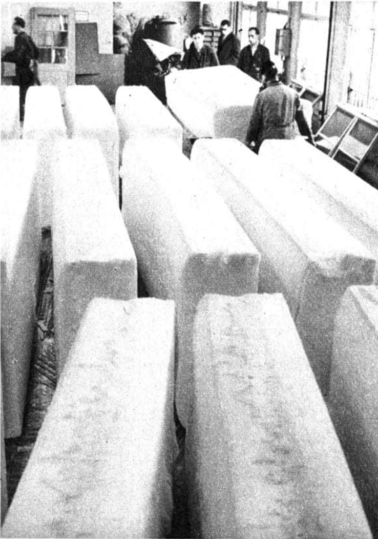
Blöcke aus Polyurethan-Weichschaum in der Lagerhalle
