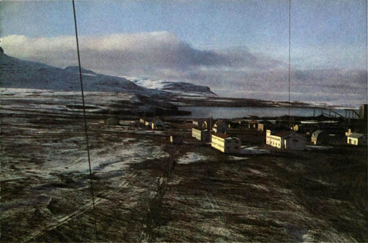
Blick auf Ny Ålesund vom Luftschiffmast
