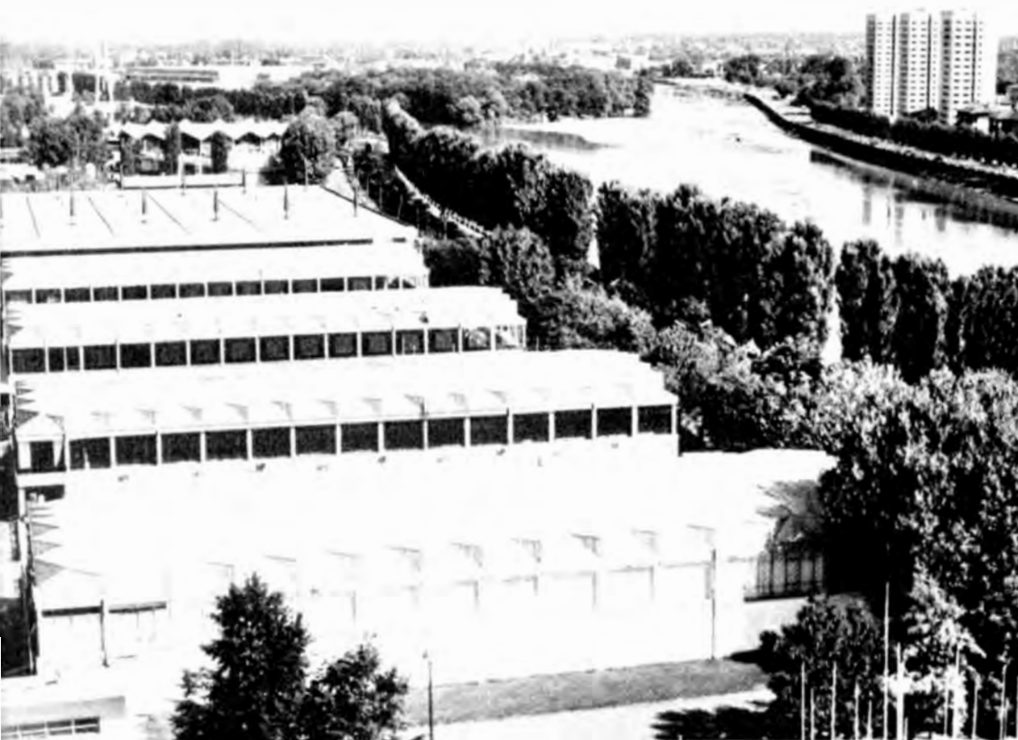
Blick vom Hotel „Mariza“ auf das Messegelände von Plovdiv
