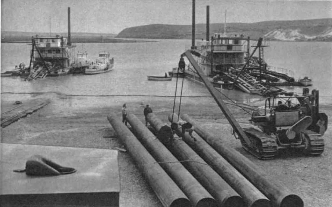
Sowjetische Schwimmbagger für den Bau des Euphrat-Staudammes werden montiert
