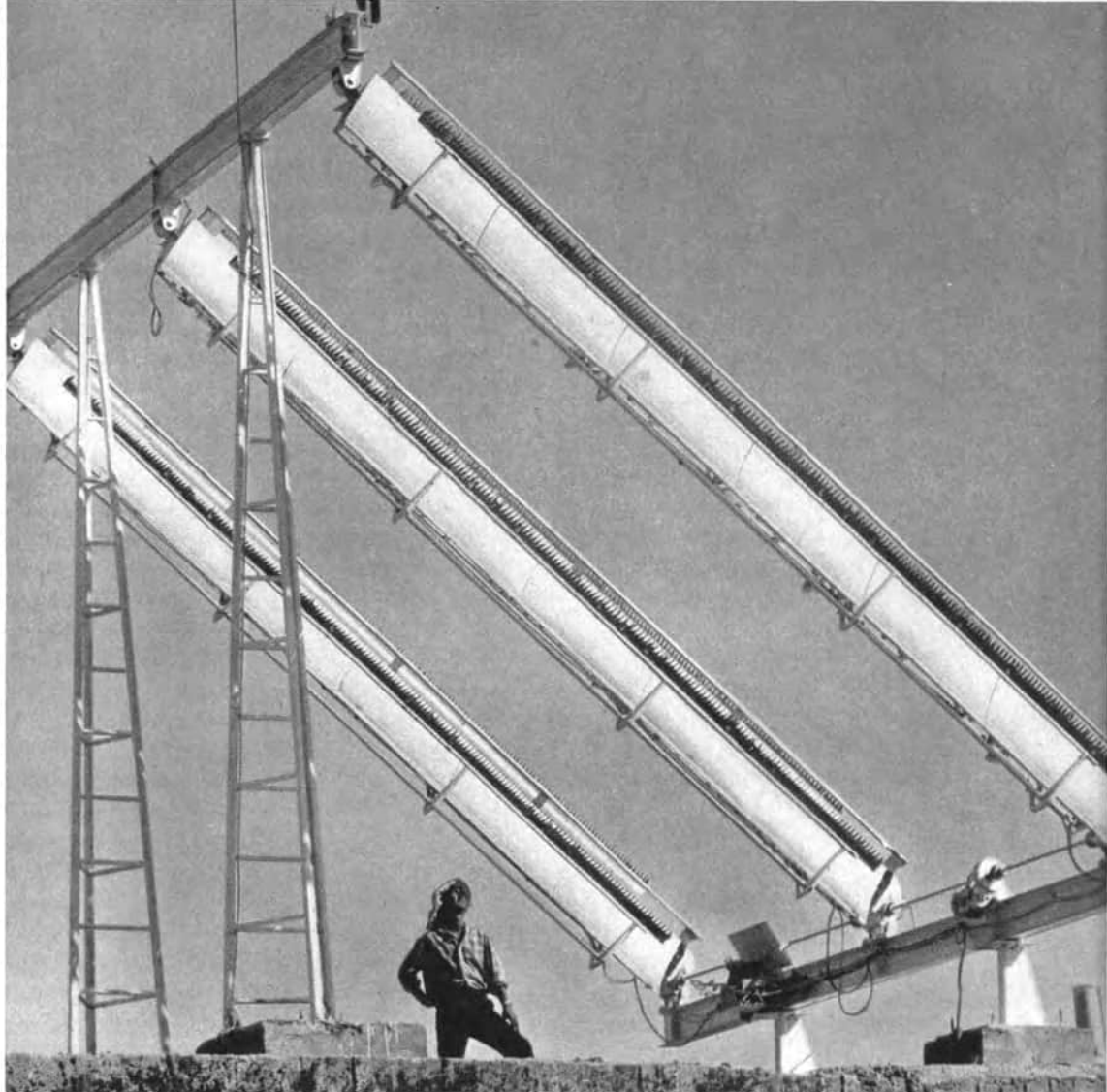
Turkmenische SSR: das Kraftwerk eines Sonnenensalzlers mit einer Leistung von 500 Watt
