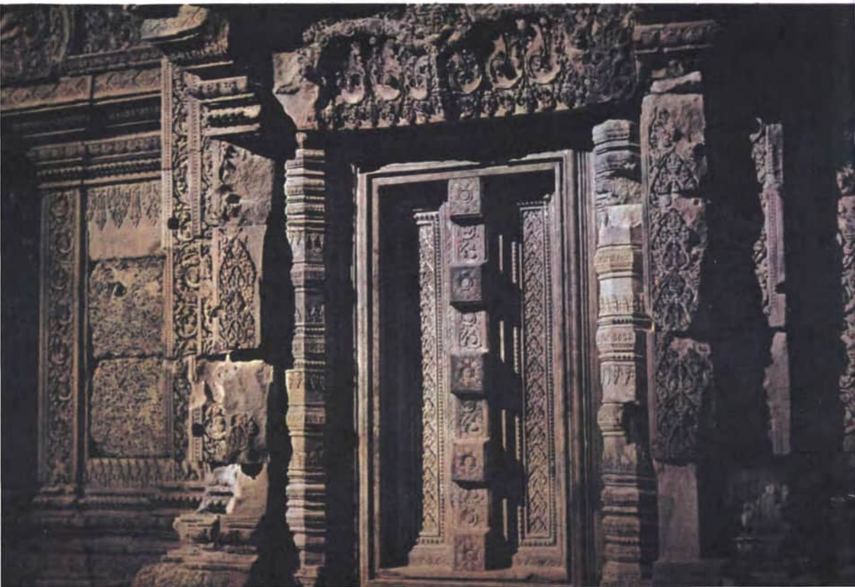
Die Detailansicht läßt die charakteristische Bauweise deutlich erkennen
