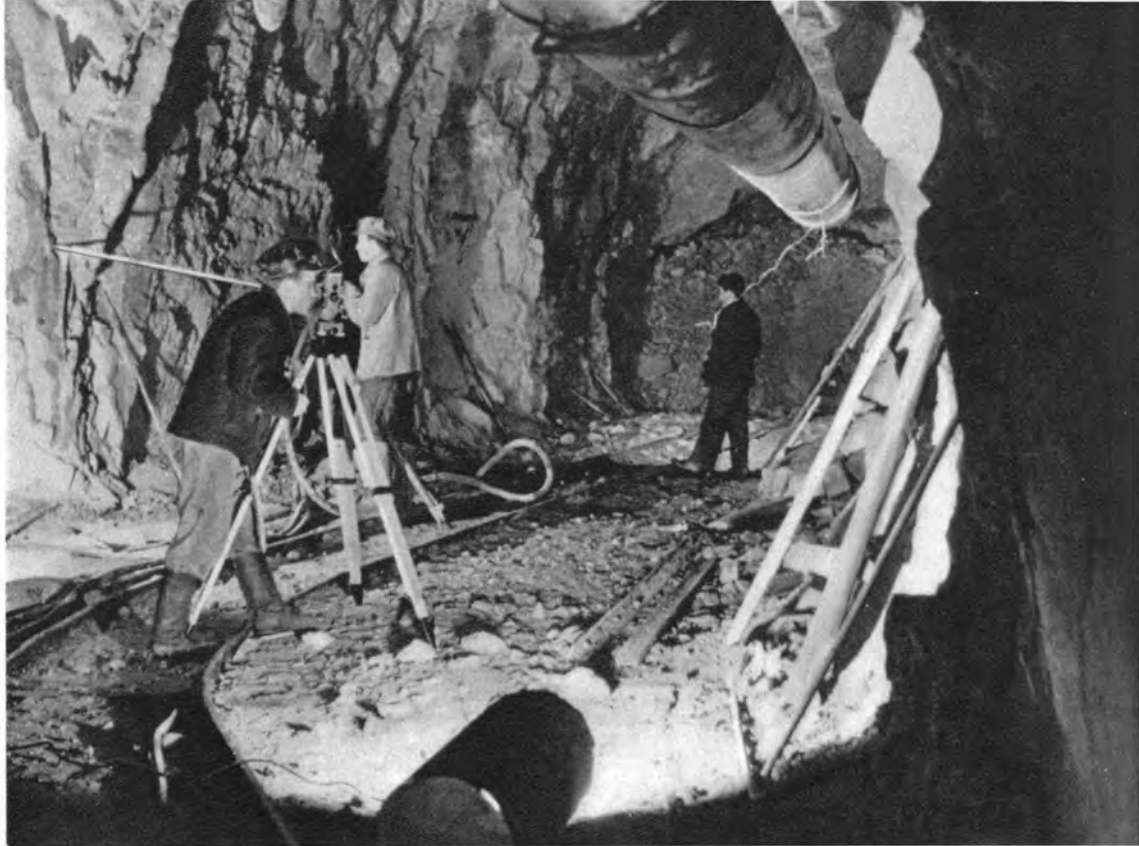
In einer der Hauptsprengekammern im Sailski Alatau (Kasachische SSR): Millionen m^3 Fels wurden in die Luft gesprengt und schufen einen künstlichen Damm gegen Schlamm- und Gerölllawinen
