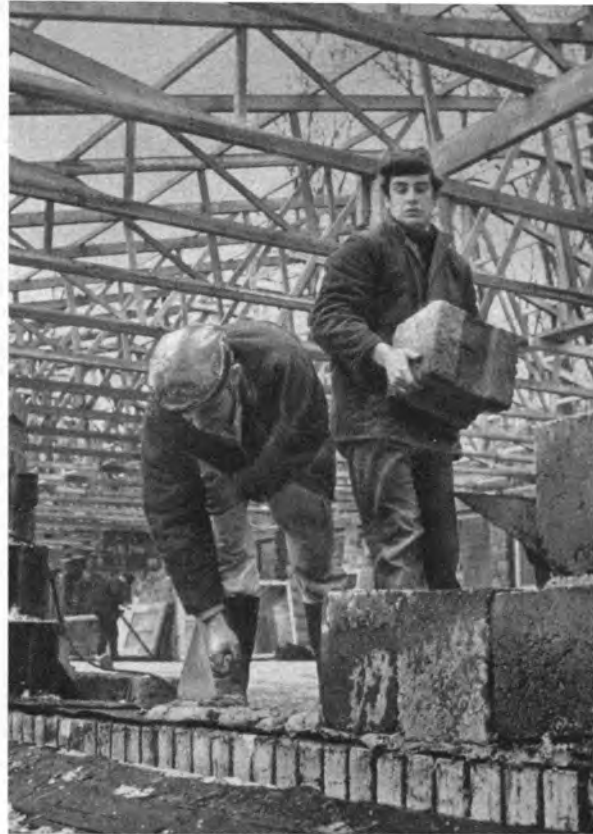
Braunkohlenfilterasche ersetzt Zement – aus den Hohlblocksteinen vom Baustoffkombinat Nobitz (links) werden z. B. Kindergärten (wie hier in der Leipziger Oststraße – rechts) errichtet
