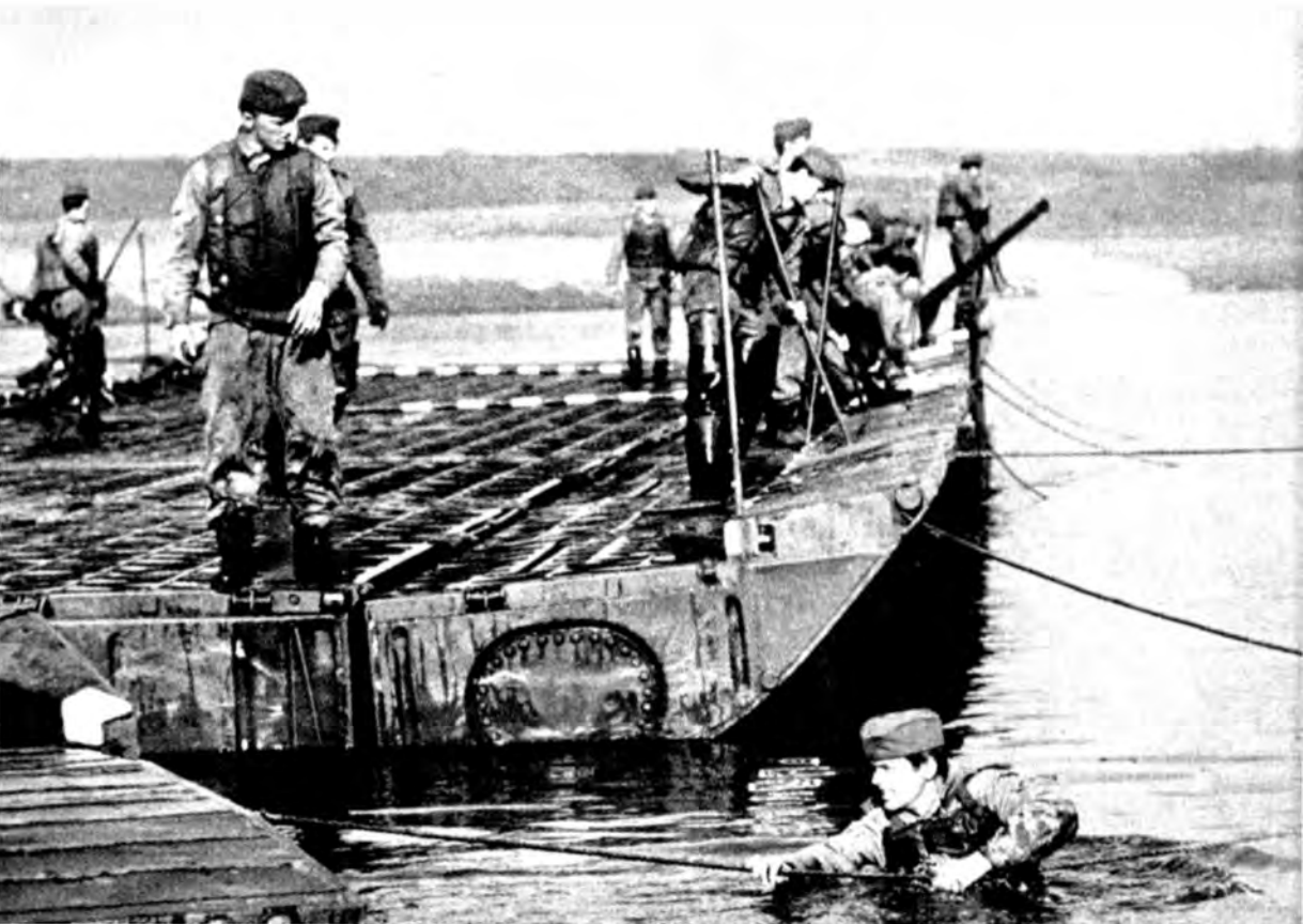
Pioniere beim Bau einer Pontonbrücke
