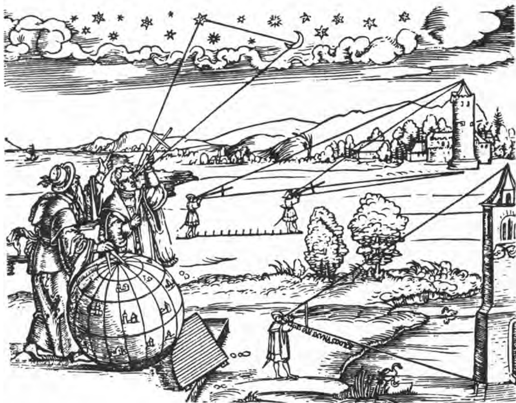
Vom 16. bis 18. Jh. war der Jakobsstab das Hauptinstrument der Seefahrer zum Bestimmen von Gestirnhöhen und -Winkeln zwischen Sternen und dadurch der geographischen Breiten
