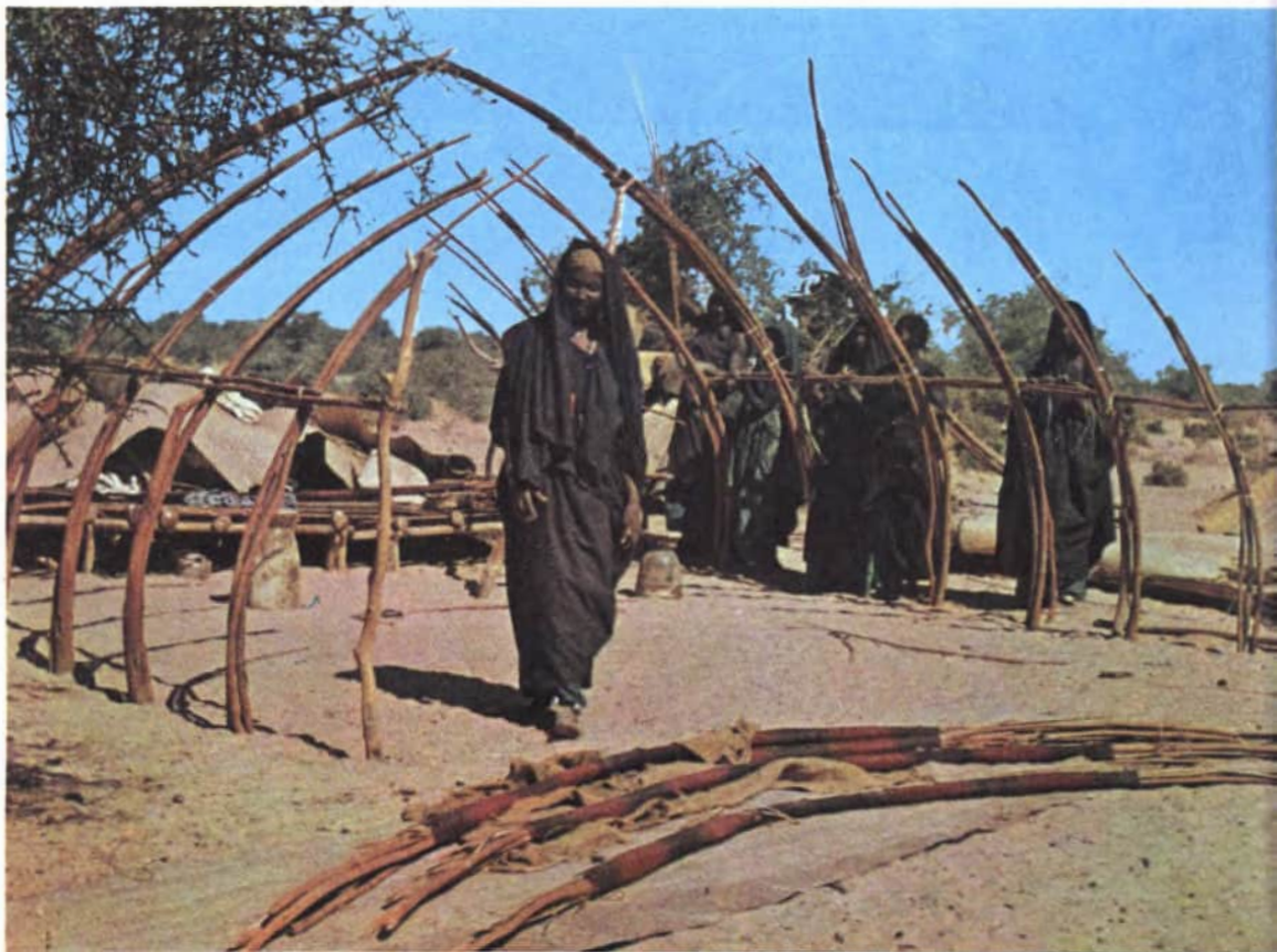
Songhai-Frauen beim Bau ihrer Hütten. Über das Holzskelett werden selbstgeflochtene Matten gelegt
