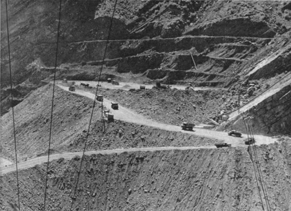
Gezielte Sprengungen größten Ausmaßes bei Nurek in der Tadshikischen SSR bereiteten einen gewaltigen Bauplatz vor: Hier entstehen am Gebirgsfluß Wachs die höchste Staumauer der Welt (Blick in das künftige Staubett – oben) und ein leistungsstarkes Wasserkraftwerk (rechts)
