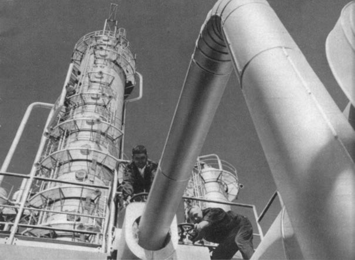
Blick auf die Pumpstation der Erdö Raffinerie von Homs (Syrien)
