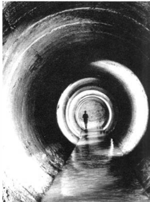
Die Tunnelvortriebsmaschine hinterläßt ein kreisrundes Profil (eine Ausmauerung der Stollenwände ist nicht notwendig)
