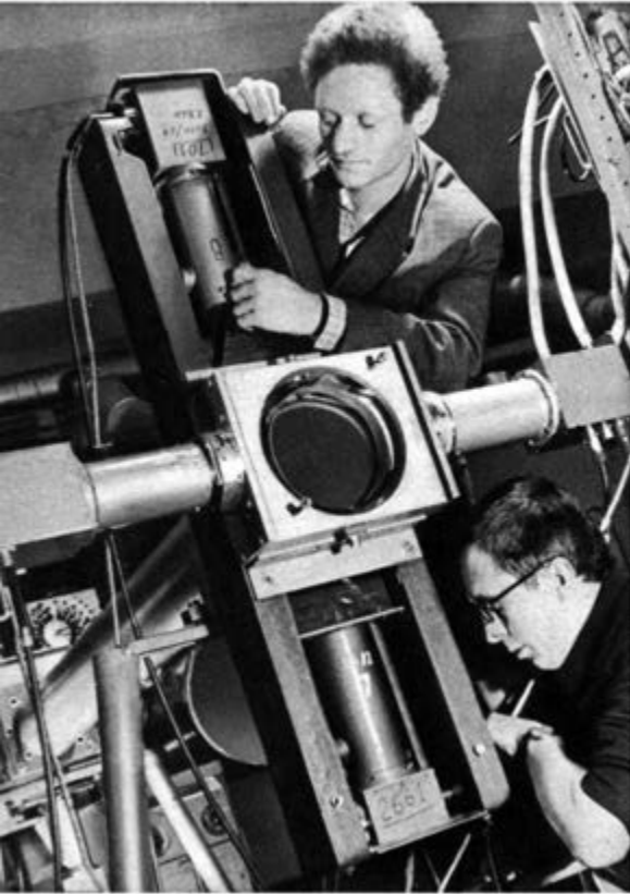
Montage eines Spektrometers, mit dem die Lebensdauer geladener Pi-Mesonen gemessen wird
