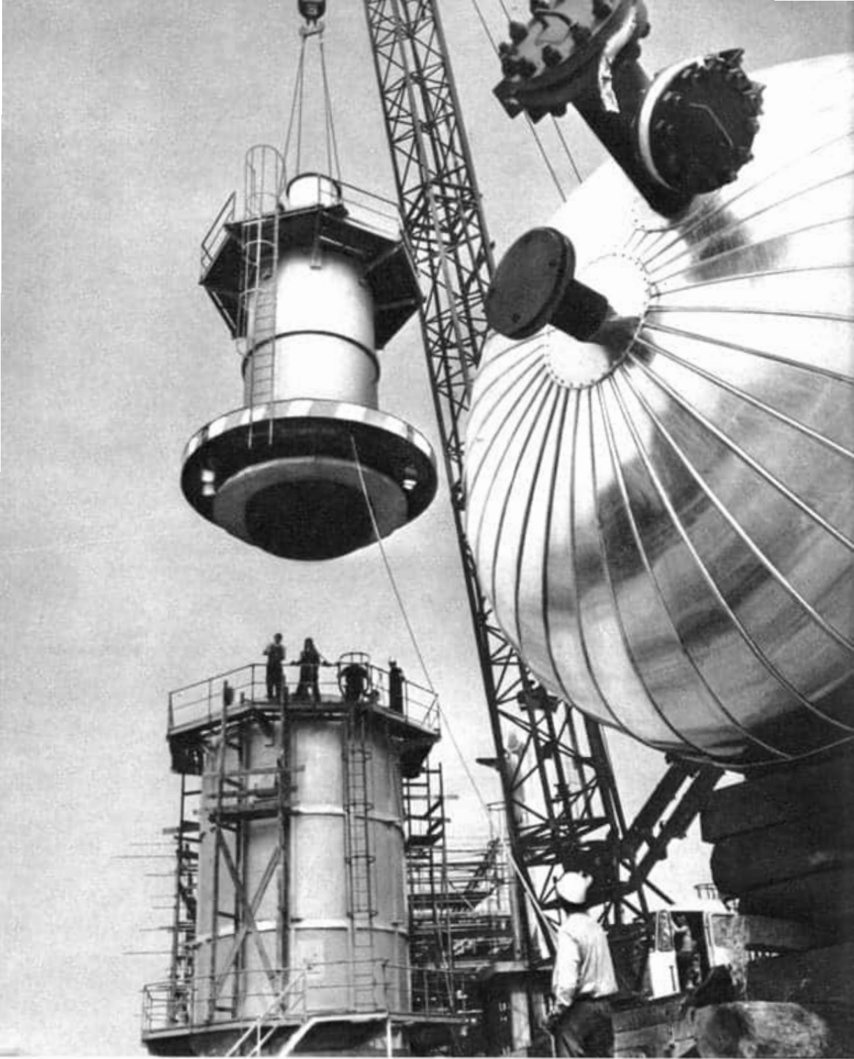
Montage der Kolonnen für die Pyrolyse-Benzin-Raffination im Investkomplex Böhlen
