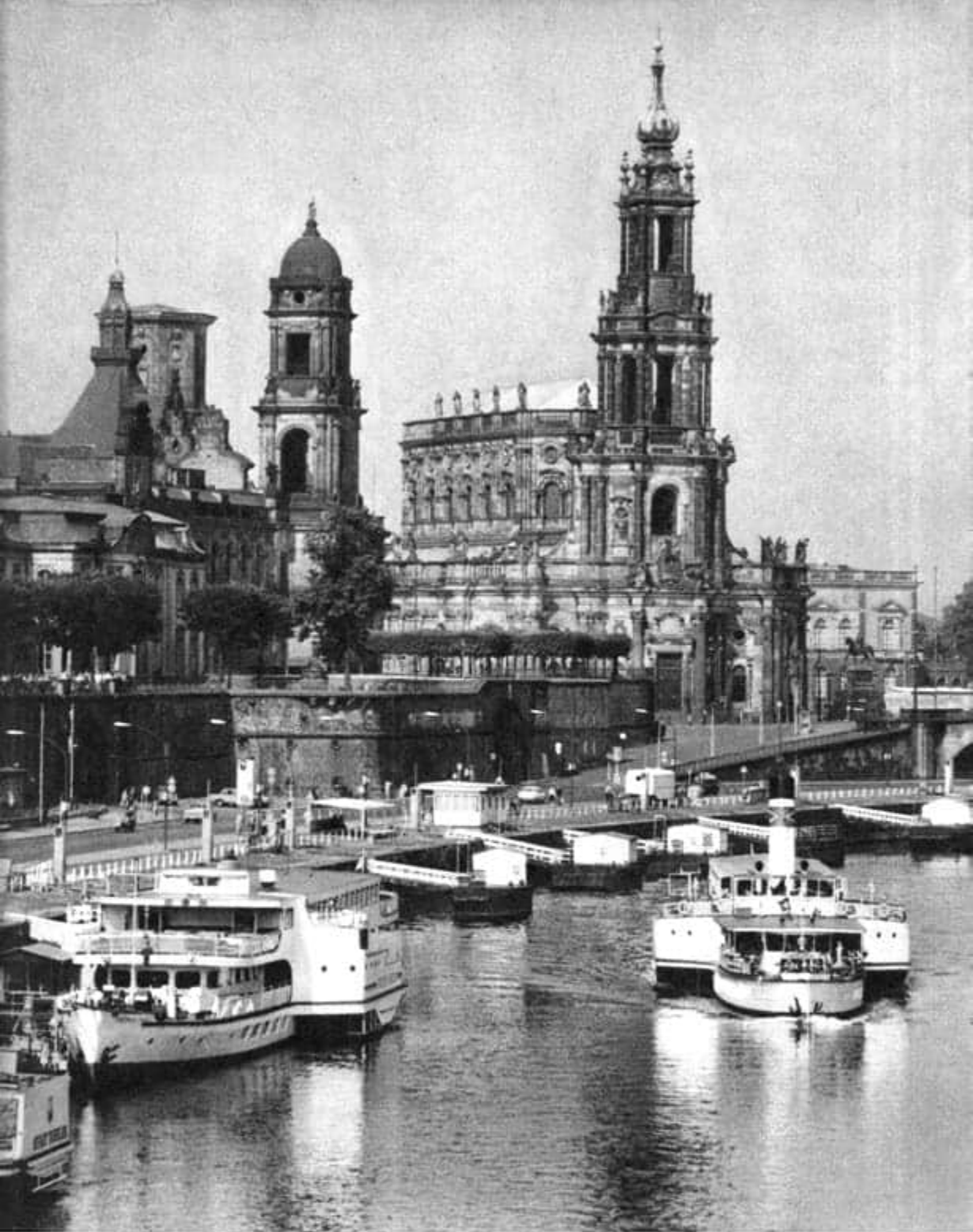
Die Hauptanlegestelle der Dresdener Weißen Flotte vor der Brühlschen Terrasse
