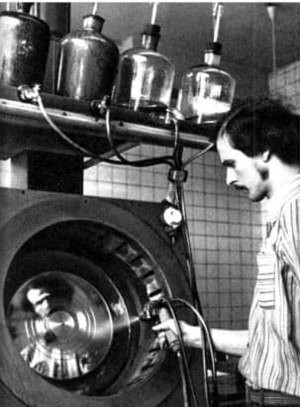
Das Versilbern der Original-Lackplatte; die Abscheidung des Silbers ist deutlich an der zunehmenden Spiegelwirkung zu erkennen Oben: der Herstellungsprozeß einer Schallplatte
