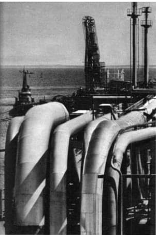
Nordhafen Gdańsk: Blick auf die Rohrleitungsbrücke; ganz rechts mechanische Ölübergabegeräte
