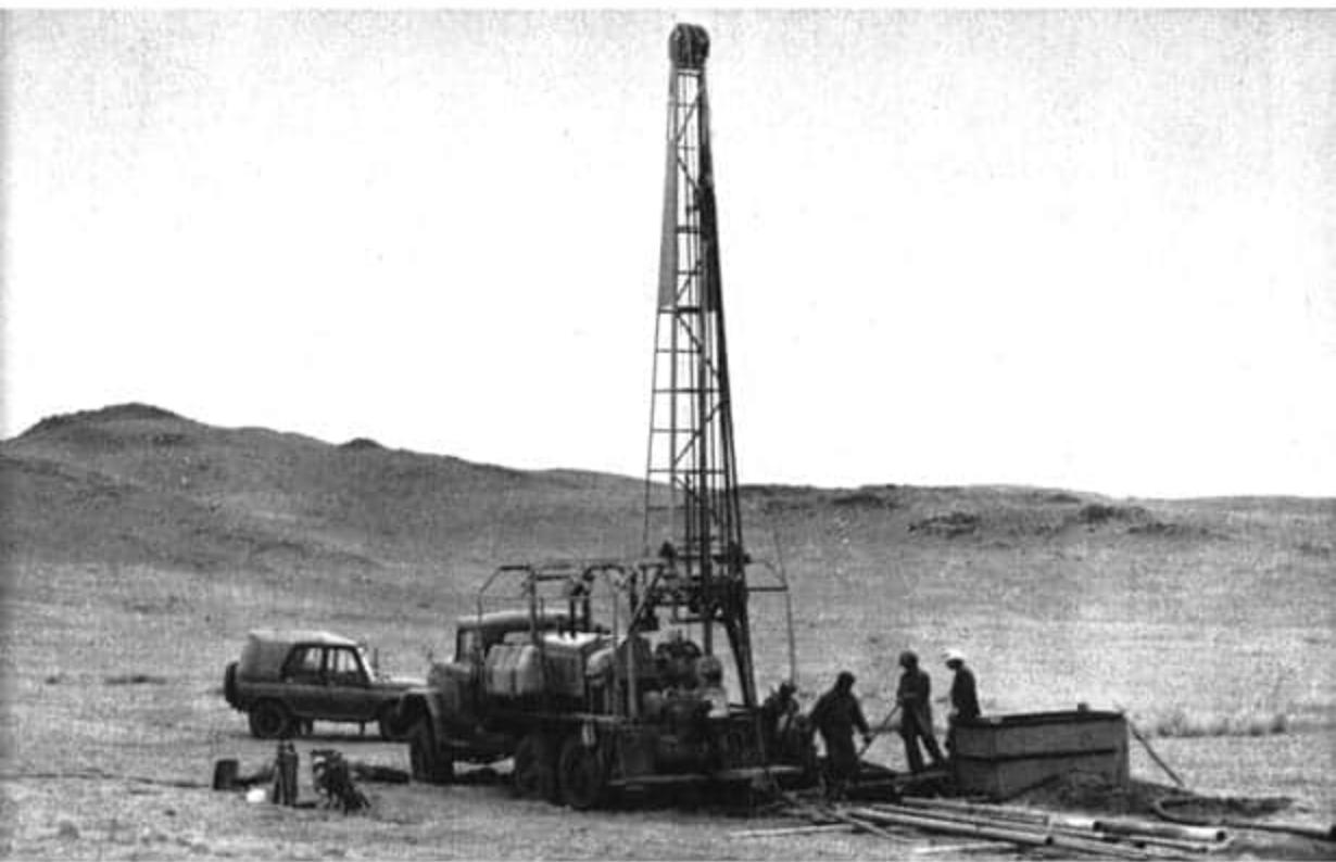
Eine Schürfbohrung wird niedergebracht
