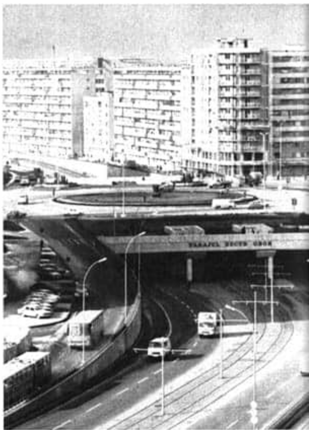
Das rekonstruierte Gebäude der Staatsbibliothek · Das Fremdenhotel »Intercontinental Bucuresti« · Großzügige Verkehrslösungen nehmen Gestalt an
