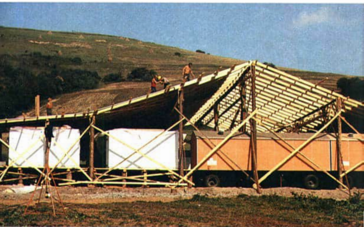
137,5 km Rohrleitung zu verlegen, drei Verdichterstationen und Wohnungen für das Bedienungspersonal zu errichten – das war ihre Aufgabe an diesem Bauabschnitt im Gebiet Iwano-Frankowsk
