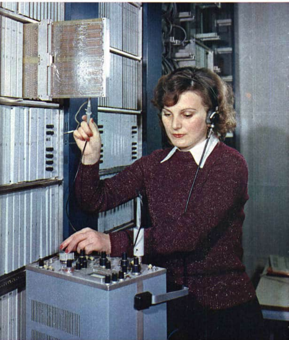
Auf dem Prüfstand: modernes RFT-Fernsprechvermittlungssystem ENSAD mit Steuerrechner vom Kombinat Robotron
