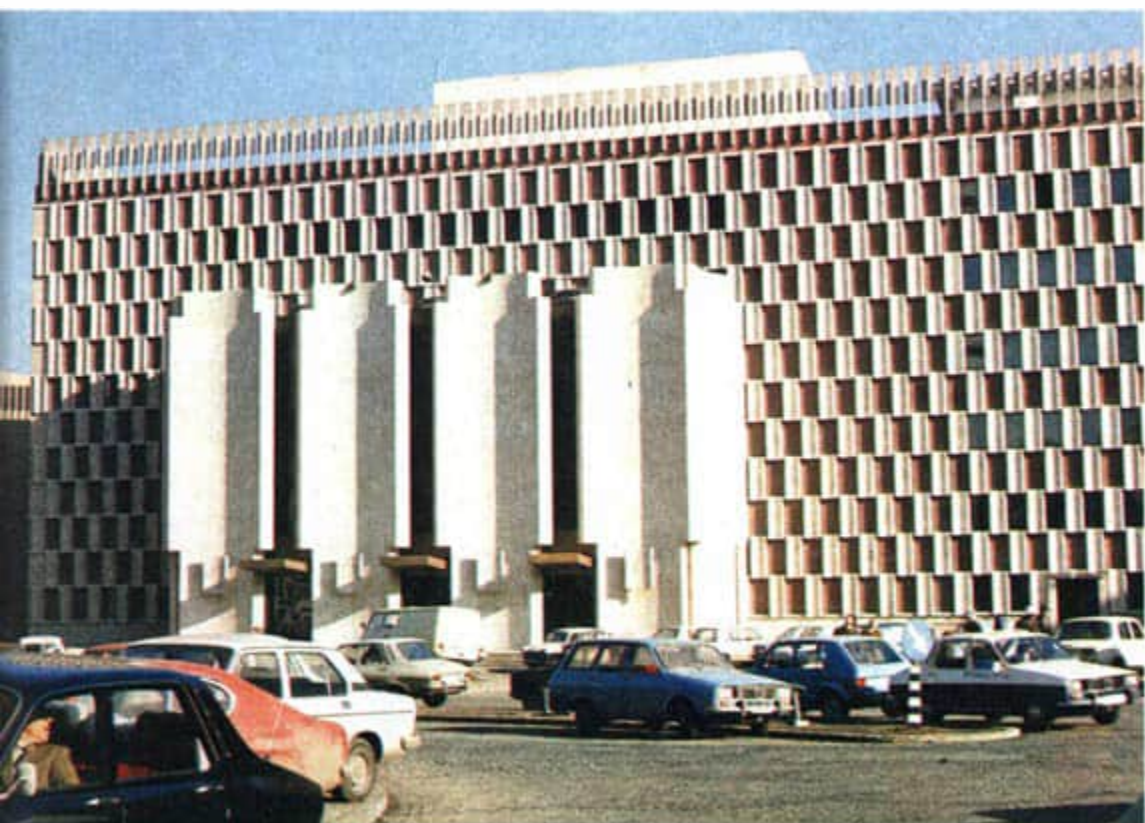
Bukarest: Das Haus der Armee (oben links); das »Athenäum«, ein berühmtes Konzert- und Ausstellungsgebäude (oben rechts); das neue Opernhaus
