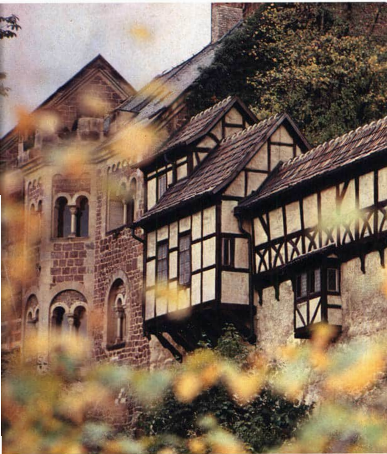
Die Ostseite der Burg nach der aufwendigen Restaurierung von 1965, die auch die Sanierung des gesamten Fachwerks, insbesondere an den Wehrgängen und der Vogtei, erfaßte
