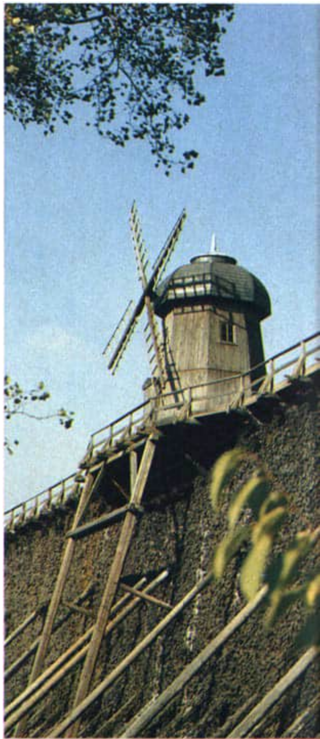
Das Gradierwerk mit der Windhebekunst in Bad Dürrenberg ist als Freiluftinhalatorium Teil der Kureinrichtung
