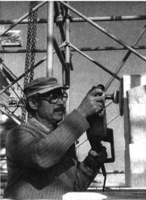
Meister Nikos Skarris bei Restaurierungsarbeiten am Erechtheion (Akropolis Athen)
