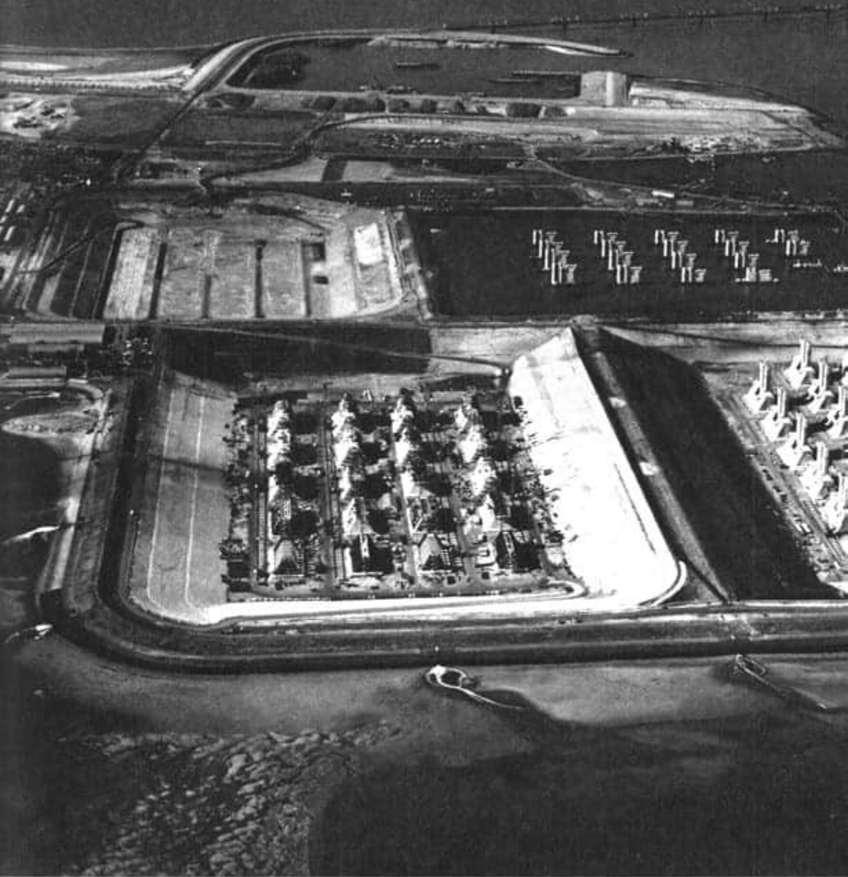
Die Arbeitsinsel in der Oosterschelde mit den Baudocks: oben – für den Transport vorbereitetes, geflutetes Dock; unten links – fertiggestellte Pfeiler; unten rechts – Pfeiler im Bau
