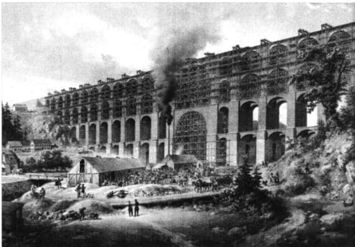
Beim Bau der Göltzschtalbrücke
