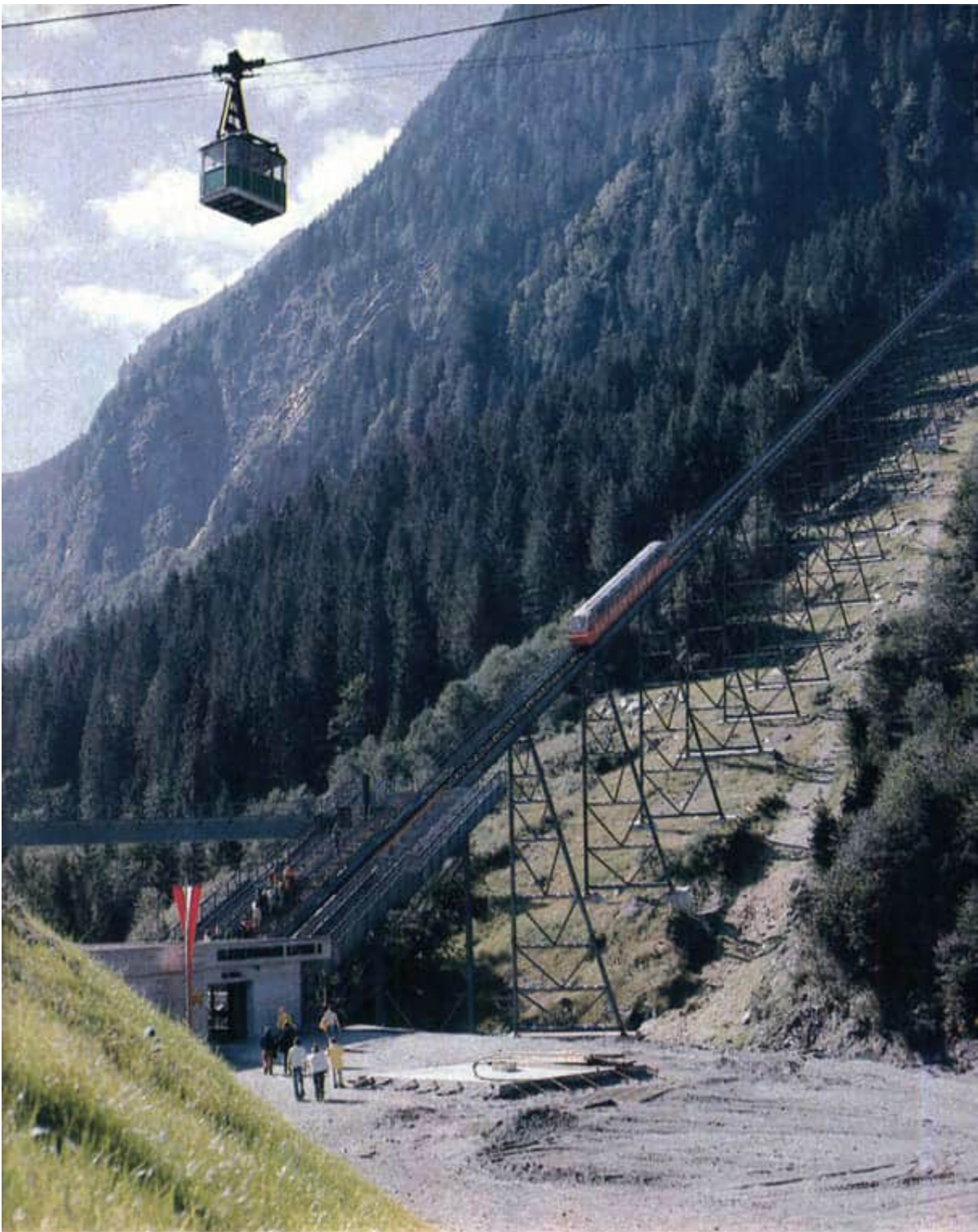
Zwei mechanische Gipfelstürmer begehen sich: die am Seil frei hängende Schwebbahn und die auf Schienen geführte Standseilbahn. Beide erschließen sie Gebiete, die ganzjährig den Wintersport ermöglichen
