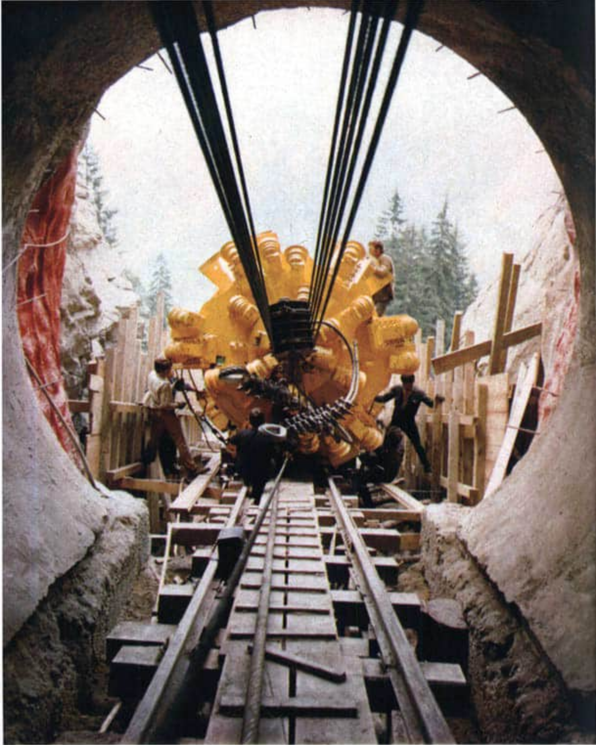
Eine Vortriebsmaschine kurz vor dem Hineinziehen in die Startröhre. Durch die Schneidwirkung der äußeren Diskenmeißel wird das Gestein abgekeilt, die Warzenmeißel im Zentrum zertrümmern es
