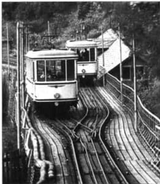
Die beiden Kabinen der Standseilbahn Dresden treffen sich auf einer 104 m langen Brücke. Seit 1976 ist sie technisches Denkmal der Verkehrsgeschichte
