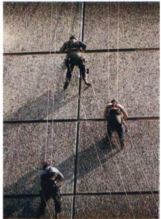
Fassadensanierung an einem Wohnhochhaus Rechts: Reparaturarbeiten an einem hohen Metallschornstein
