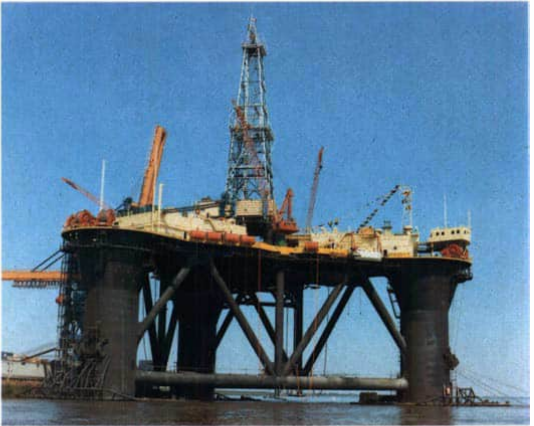
Eine halbtauchende Bohrplattform im Hafen. An der Seite des Decks befinden sich die kollektiven Rettungsmittel (geschlossene Rettungsboote und sich selbst aufblasende Rettungsinseln in Behältern)
