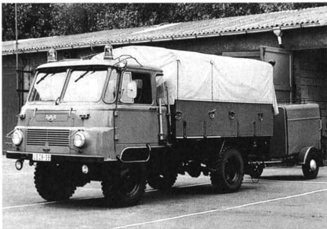
Löschfahrzeug 8 (LF) mit Schlauchtransportanhänger (STA), Standardfahrzeug der Freiwilligen Feuerwehren bis heute
