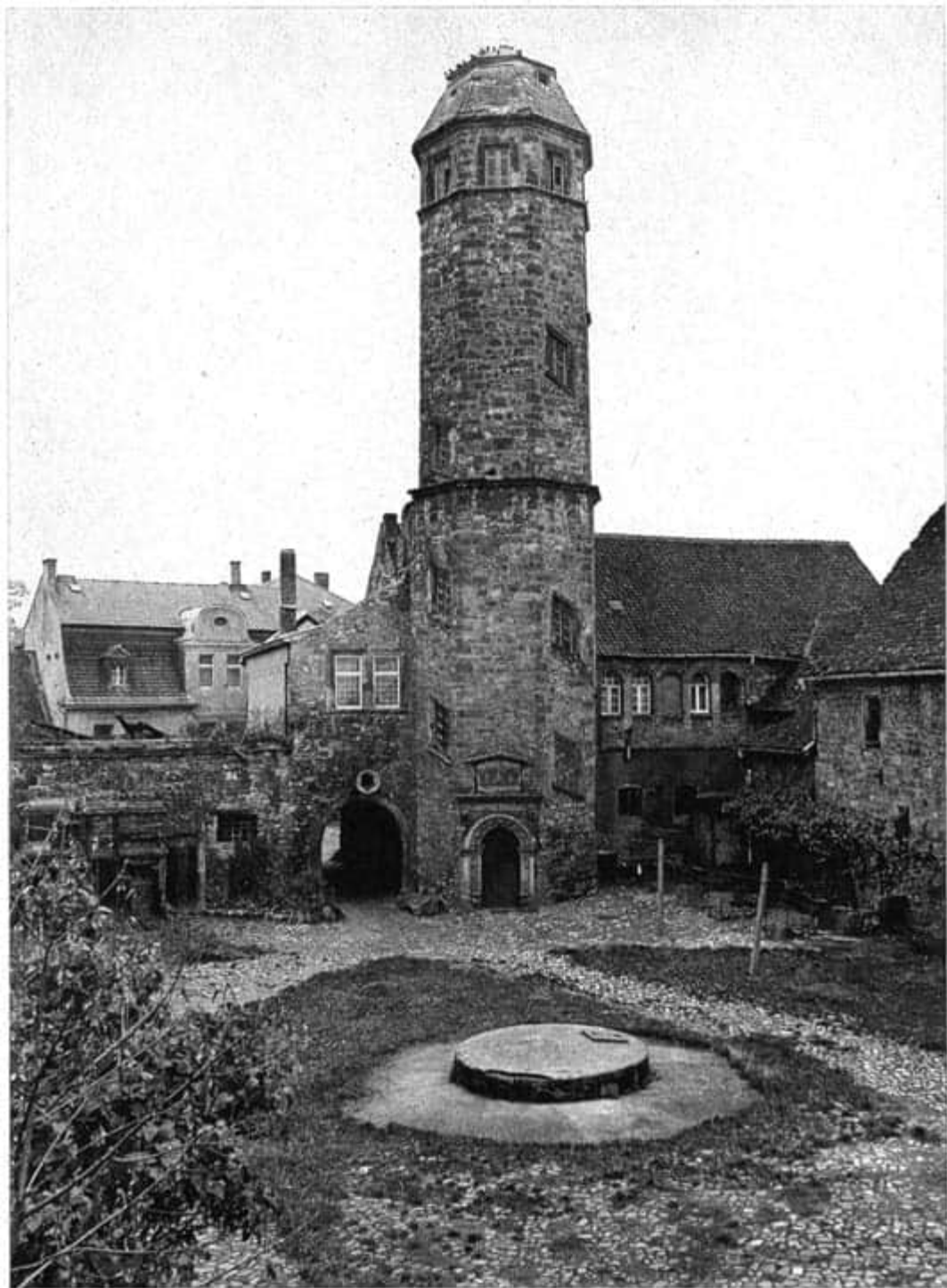
Technisches Denkmal: Station Nr. 16 im oberen Teil des Treppenturms des Renaissanceschlosses in Ampfurt
