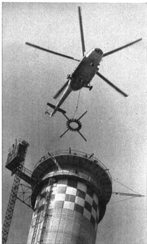
»Arbeitspferd der Lüfte« – mittels eines Hubschraubers wird an einem 160 m hohen Kraftwerksschornstein die Gleitschalung erneuert
