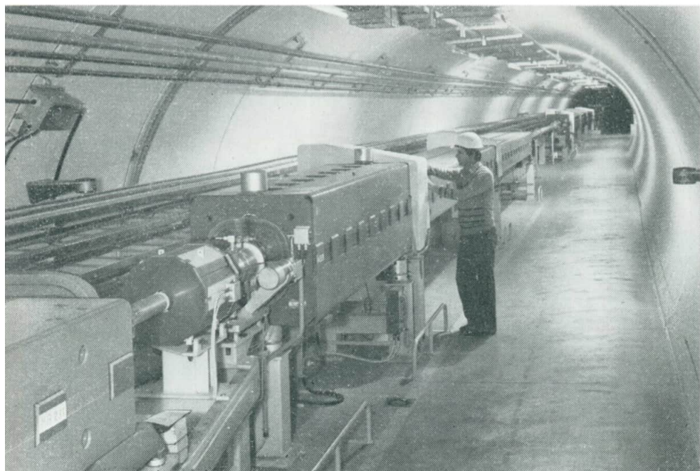
Blick in den Tunnel des Super-Protonen-Synchrotrons des Kernforschungszentrums CERN
