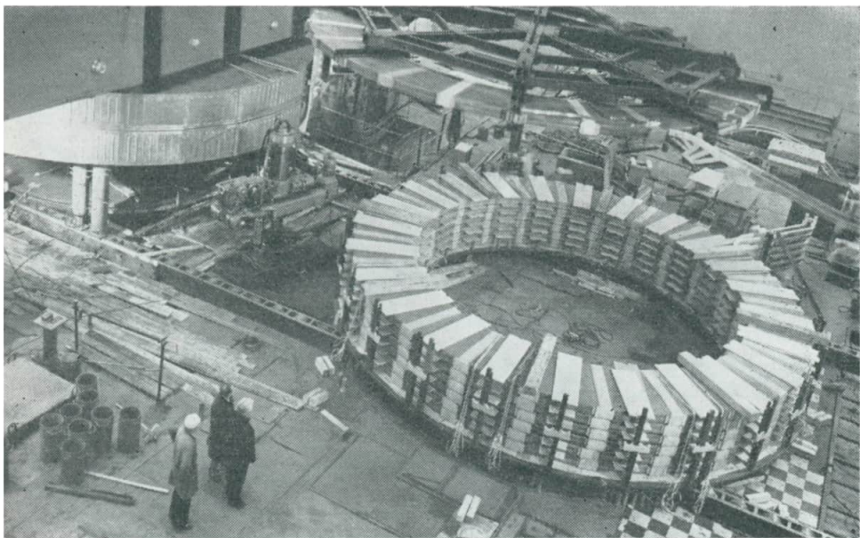
Während der Rekonstruktion des Synchrozyklotrons in Dubna
