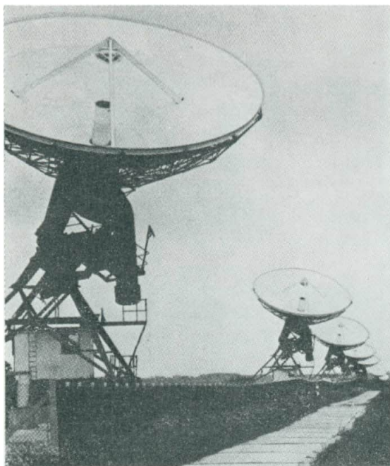
Eine Batterie beweglicher Radioteleskope ermöglicht hochgenaue Messungen nach dem Prinzip der Apertursynthese – hier die Anlage des Observatoriums Cambridge.
