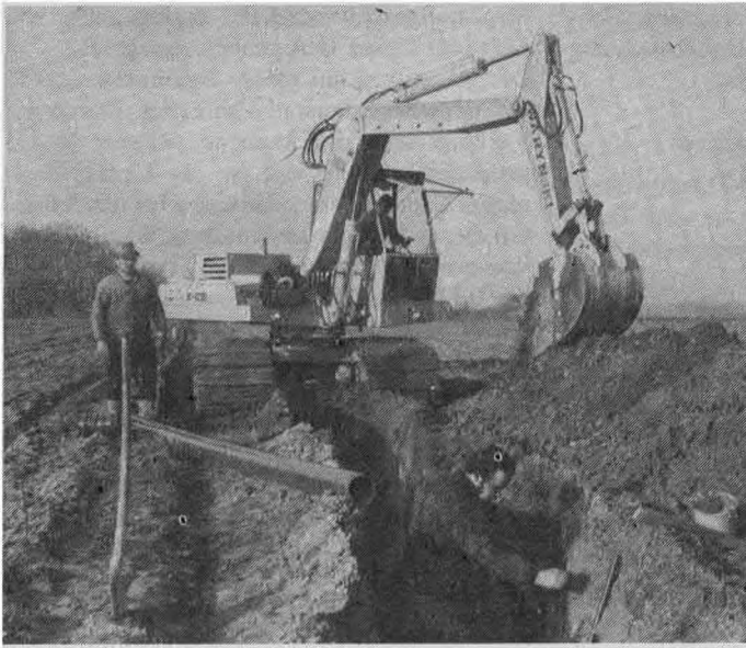
Abb. 4/13 Einsatz moderner Technik bei der Verlegung von Bewässerungssystemen
