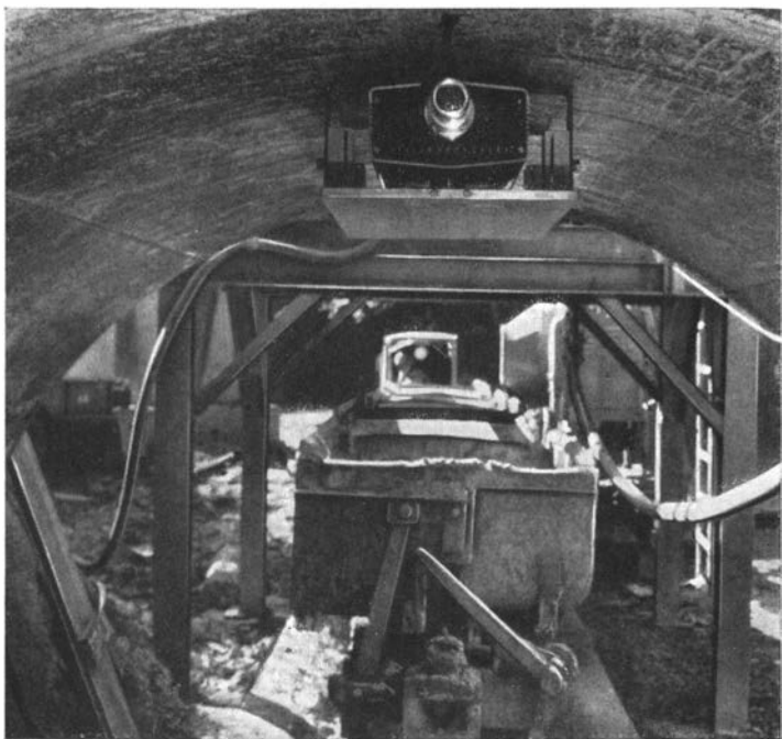
Bild 13. Meßtechnischer Einsatz des Lasers beim Bau eines U-Bahn-Tunnels
