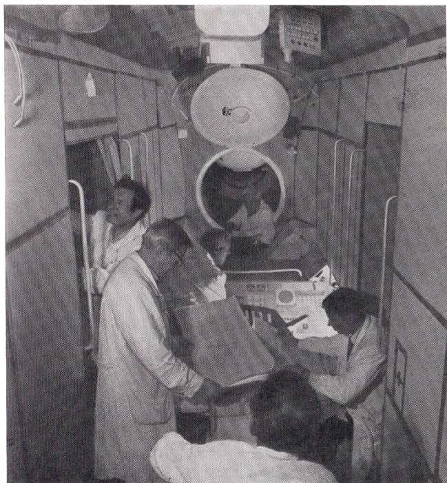
Montagearbeiten im Salut
