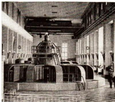
Überdruckturbinen benötigen große Wassermengen bei einer kleinen Gefällhöhe.
