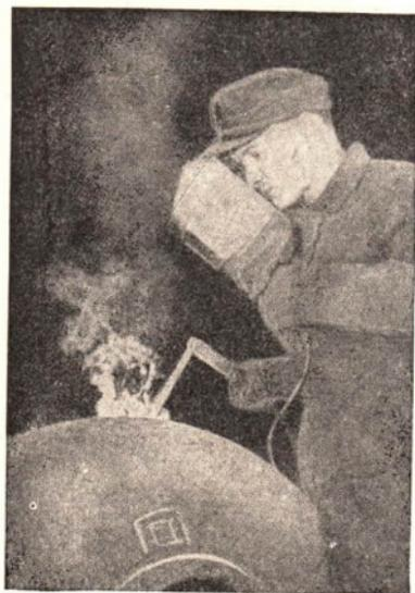
Abb. 182/2. Elektrisches Lichtbogenschweißen
