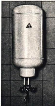
Abb. 51. Elektrischer Warmwasserbereiter aus dem IKA-Werk Elektrowärme Sörnewitz VEB
