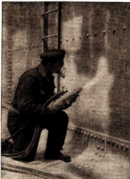
Abb. 35 Spritzverzinken eines Troges vom Schiffshebewerk Rothensee
