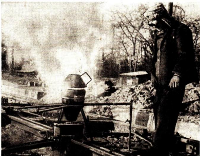
Schweißen von Straßenbahnschienen nach dem aluminothermischen Verfahren
