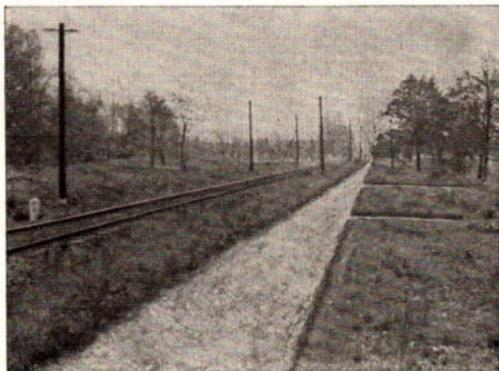
Abb. 5 Feuerschutzgraben an einer Eisenbahnstrecke
