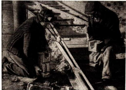
Abb. 50 Ansetzen der beiden Hälften der Gußform
