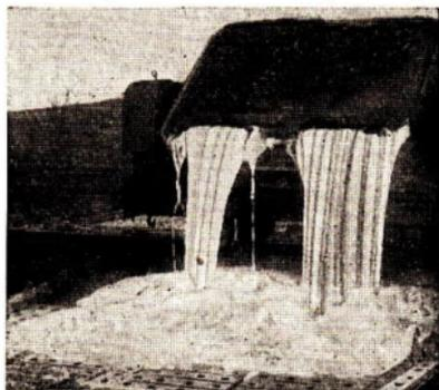
Abb. 49. Die bei der Gewinnung des Kupfersteins entstehende glühende Schlacke wird zu Pfastersteinen vergossen.
