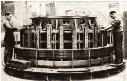
Abb. 49/1. Montage eines großen Trommelankers
