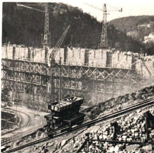
Abb. 167. Schrägaufzug auf dem Baugelände der am 21. 12. 51 eingeweihten Talsperre des Friedens bei Sosa. Er diente zum Befördern von Erde und Steinen. Im Hintergrunde die Talsperrenmauer im Bau, von der Wasserseite her betrachtet.
