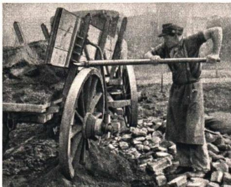
Abb. 130. Hebebaum beim Hochheben der Seitenwand eines Wagens
