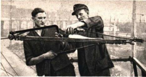
Abb. 156. Spannen des Fahrdrabtes einer elektrischen Straßenbahn beim Ausführen einer Reparatur. Die beiden Arbeiter stehen auf der Plattform eines Turmwagens. Sie haben an die beiden Enden des Drahtes zwei flache, mit Haken versehene Haltevorrichtungen geklemmt. Mit Hilfe eines dazwischen befestigten Flaschenzuges werden die Drahtenden gespannt. Von den sechs Verbindungseilen werden drei durch die davorliegenden verdeckt.
