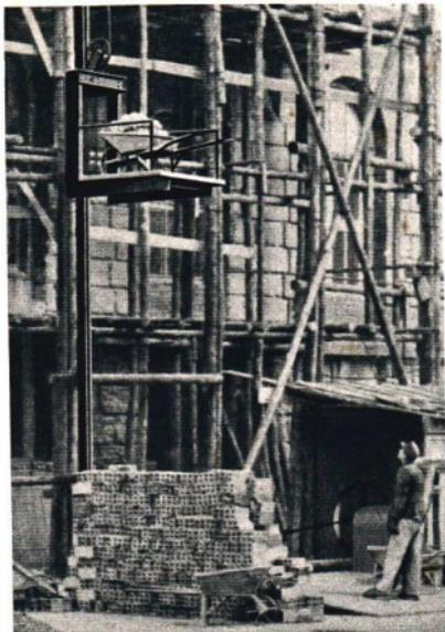
Abb. 195. Lastenaufzug an einem Neubau
