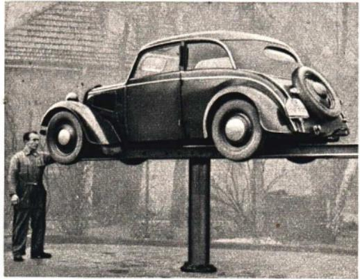
Abb. 95. Hydraulischer Wagenheber
