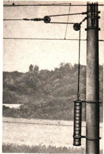
Abb. 157. Einfacher Flaschenzug als Halte- und Spannvorrichtung für den Fahrdrabt einer Straßenbahn. Verwendet wird eine lose, eine feste Rolle und an Stelle des Seils eine Kette. Sie wird durch schwere Betonscheiben gespannt. Die auf den Fahrdrabt ausgeübte Zugkraft ist doppelt so groß wie das Gewicht der Betonscheiben.
