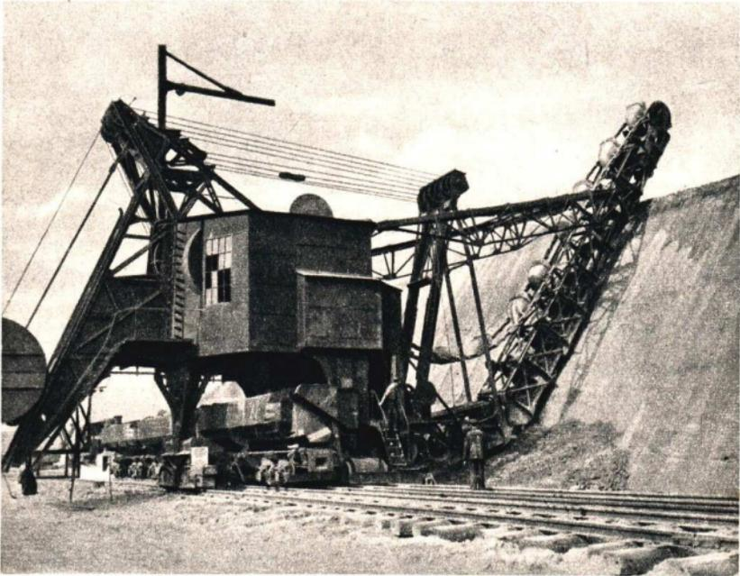
Abb. 78. Abraumbagger im Tagebau einer mitteldeutschen Braunkohlengrube
