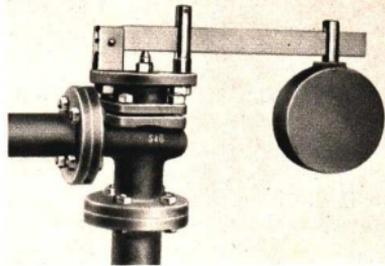
Abb. 136. Sicherheitsventil an einer Dampfleitung
