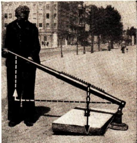
Abb. 106/1. Anheben eines Kanaldeckels
