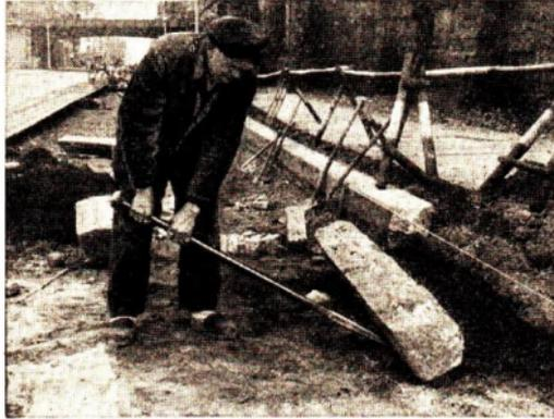
Abb. 59/1. Anheben eines schweren Steines mit Hilfe einer Brechstange
