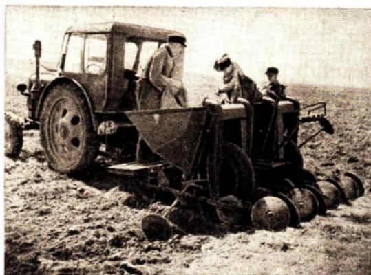
Abb. 19 Kartoffellegemaschine bei der Arbeit.
