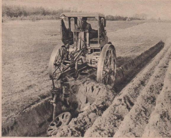
Abb. 2 Zum mellorativen Pflügen gebrüchlicher Rigolpflug CE 24 V
