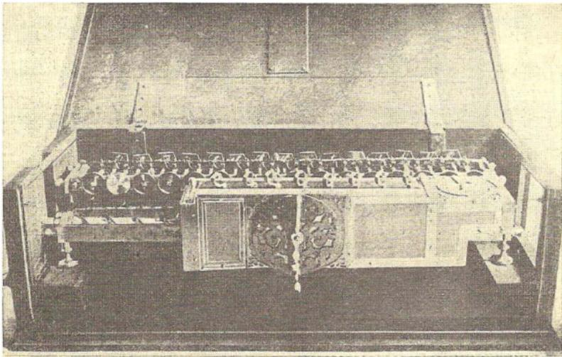
Die von Leibniz konstruierte Rechenmaschine
