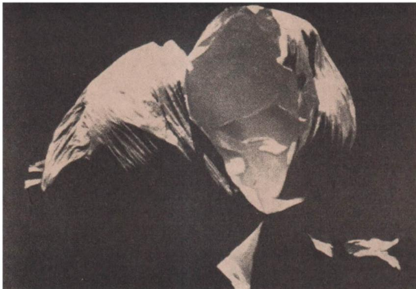
**Der Ballonsatellit Echo 2 platzte während des Aufblasens bei einem Höhentest am 15. Januar 1962. Dieses Foto wurde von einer in der letzten Raketstufe installierten Fernsehkamera aufgenommen**
