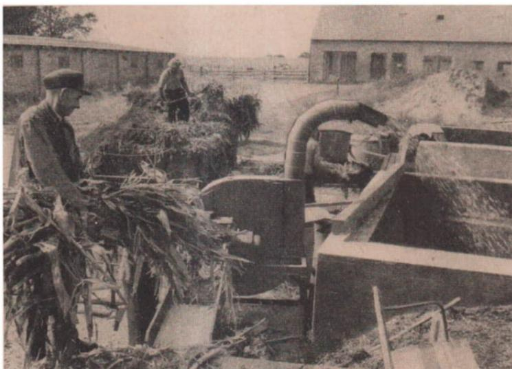
Abb. 25 Silieren von Mais und Klee. Die Häckselmaschine im Vordergrund verarbeitet den frisch geernteten Mais; die Maschine im Hintergrund häckseln den Klee
